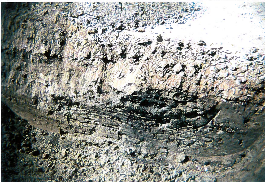
PHOTO 3 - Traces de contamination sur la paroi
