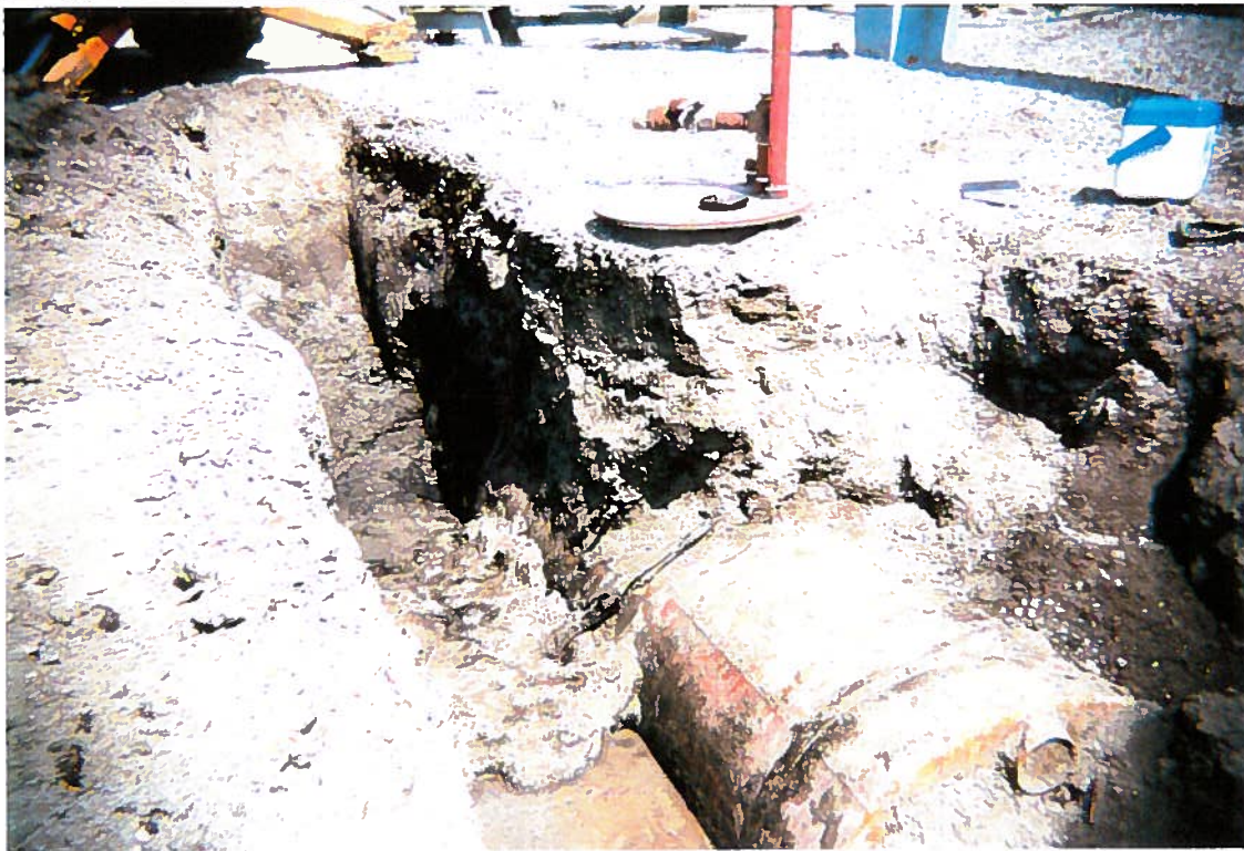
PHOTO 9 - Dégagement complet du réservoir
