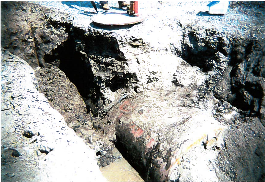
PHOTO 8 - Poursuite de l'excavation à proximité du réservoir souterrain
