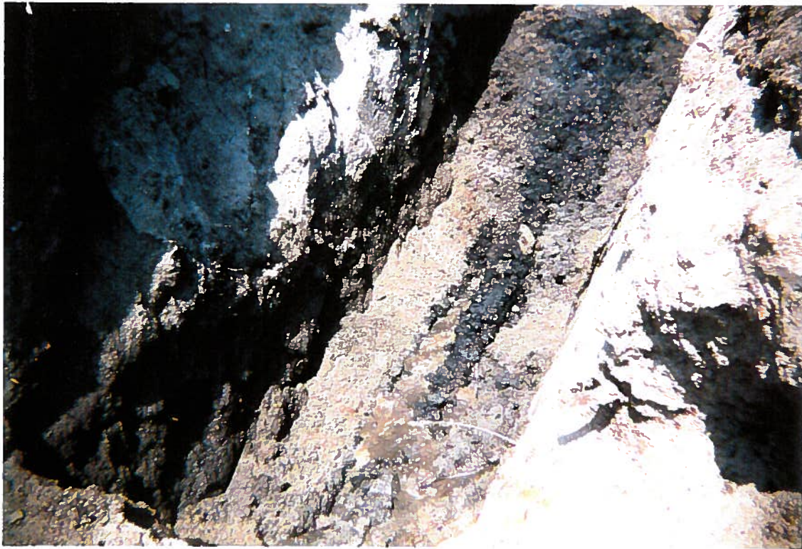
PHOTO 12 - Traces noirâtres au fond de la tranchée d'observation #1
