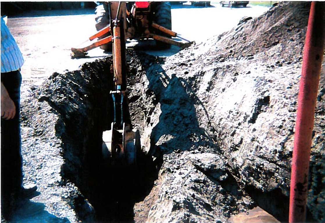
PHOTO 5 - Poursuite de l'excavation de la tranchée #1 vers le sud
