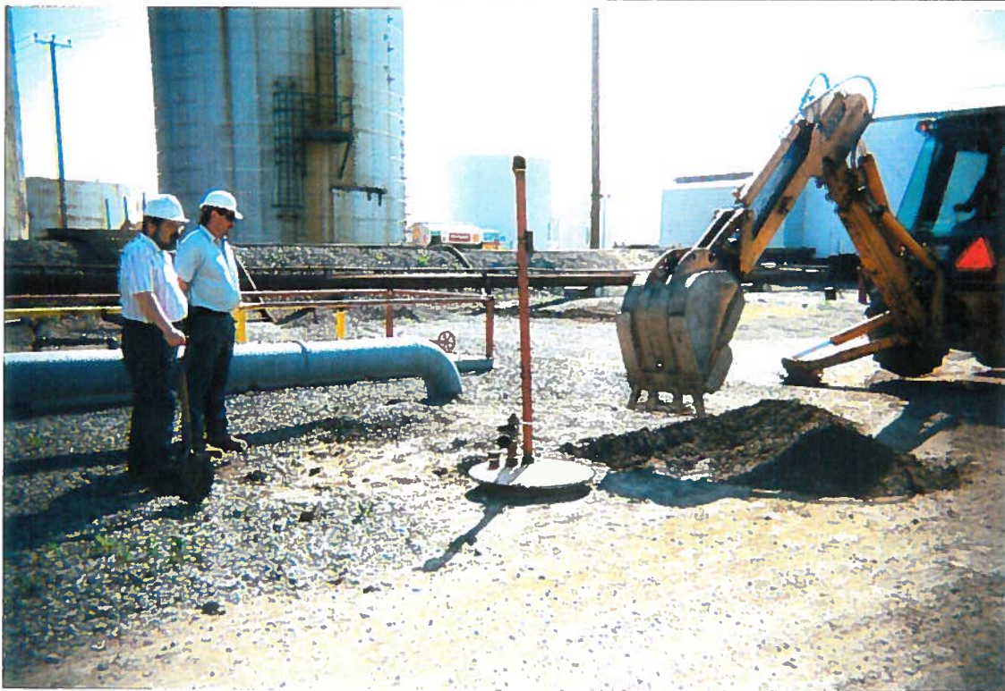
PHOTO 1 - Excavation de la tranchée d'observation à proximité du réservoir de captation souterrain (tranchée #1)
