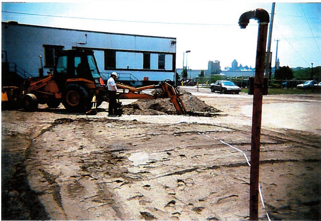
PHOTO 17 - Excavation de la tranchée d'observation #2
