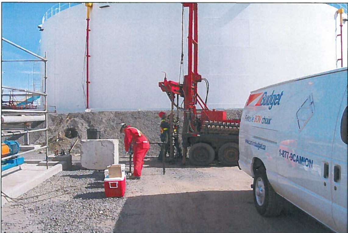
Photo 14 : Réalisation du forage F09-03 (anciennement F96-12) situé à l'intérieur du terminal 2 (4 mai 2009).
