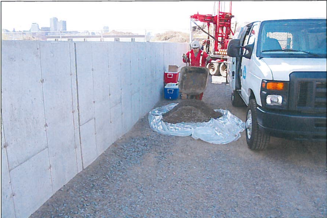
Photo 3 : Récupération des débris de forage et accumulation sur une membrane de plastique (4 mai 2009).
