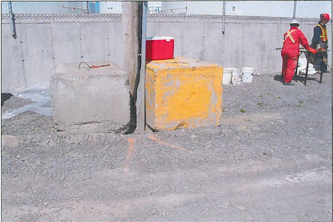
Photo 11 : Localisation en surface du sol de l'emplacement des câbles de communication souterrains par l'entreprise Bell Canada (4 mai 2009).
