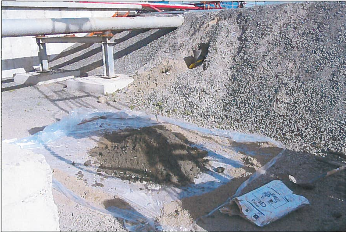
Photo 17 : Accumulation des déblais de forage de F09-03 sur une membrane de plastique (4 mai 2009).
