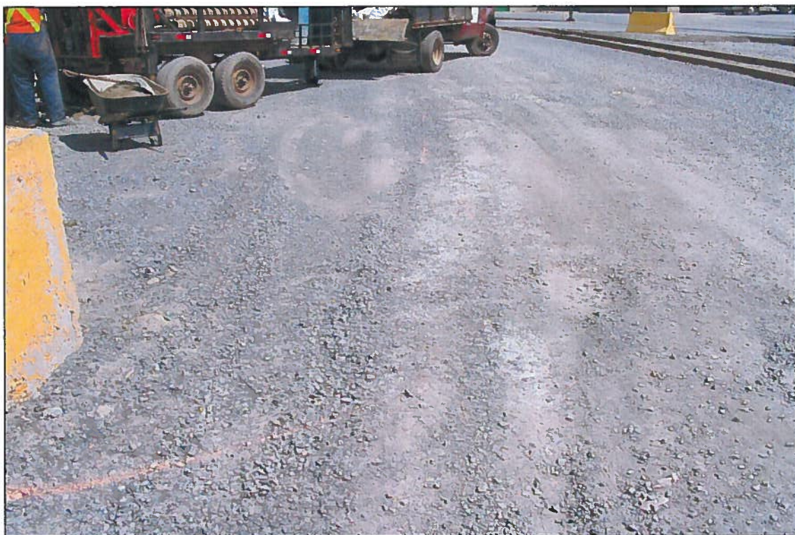
Photo 10 : Localisation en surface du sol de l'emplacement des câbles de communication souterrains par l'entreprise Bell Canada (4 mai 2009).
