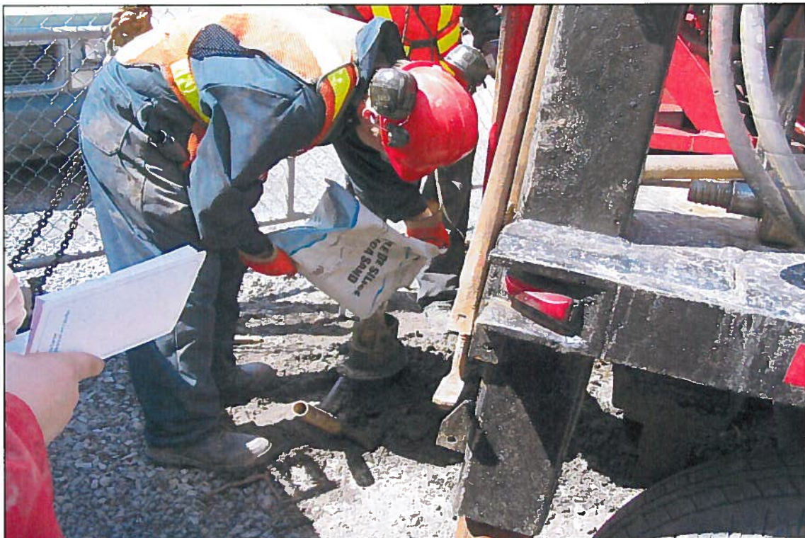
Photo 4 : Aménagement du puits d'observation F09-01, selon les spécifications décrites à la section 2.1.2 (4 mai 2009).
