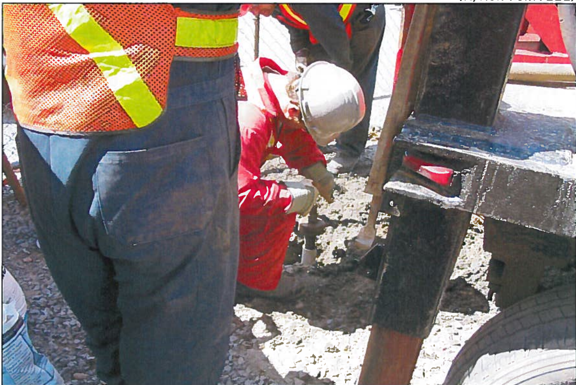
Photo 5 : Aménagement du puits d'observation F09-01 (4 mai 2009).
