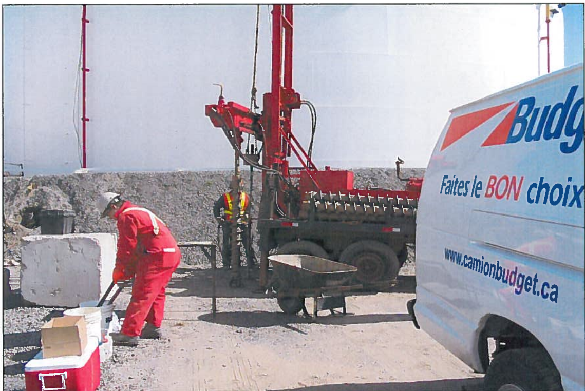
Photo 16 : Nettoyage des instruments d'échantillonnage du sol après chaque prélèvement (4 mai 2009).
