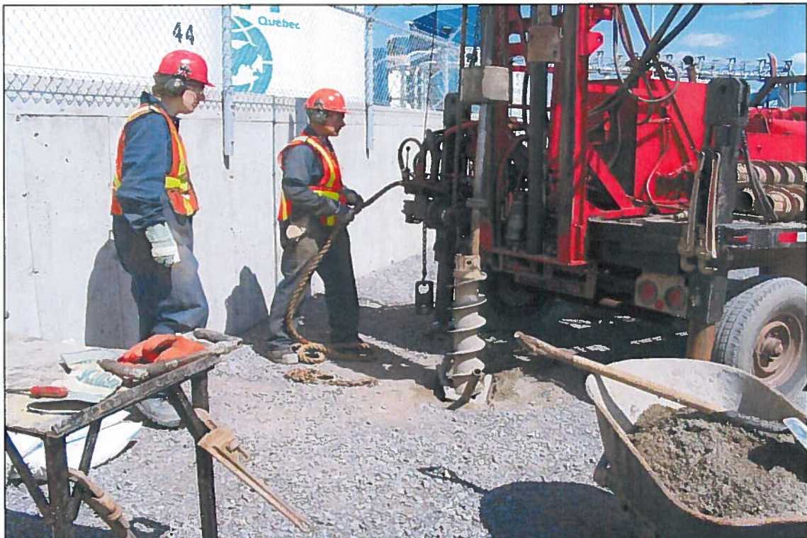
Photo 12 : Réalisation du forage F09-02 à l'aide de la tarière évidée (4 mai 2009).
