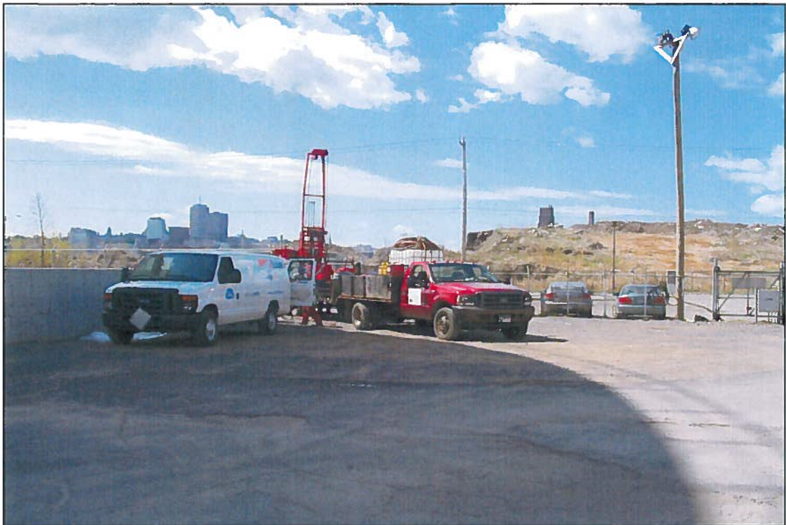
Photo 1 : Vue générale de l'emplacement du forage F09-01 situé à l'intérieur du terminal 2 (4 mai 2009).
