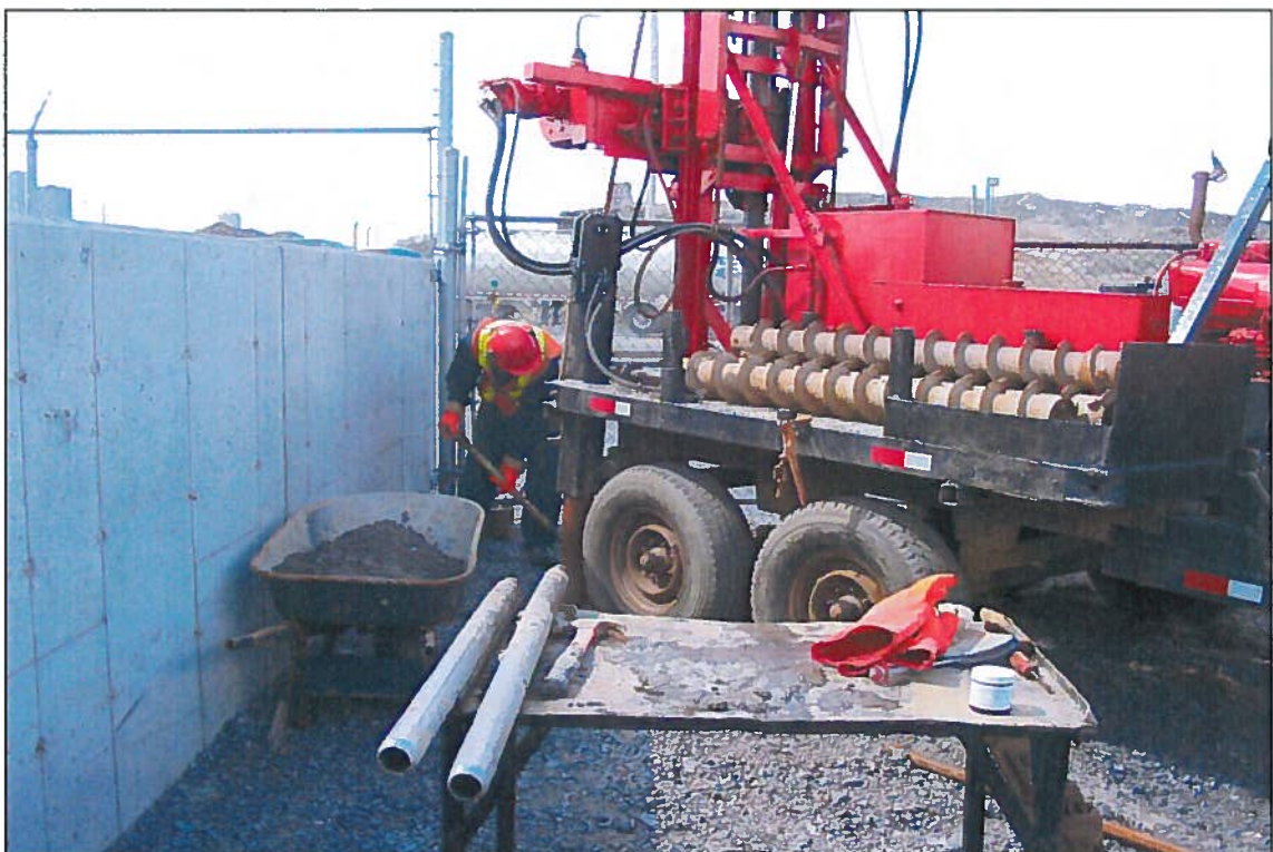
Photo 2 : Réalisation du forage F09-01 (anciennement le puits F05-07) (4 mai 2009).
