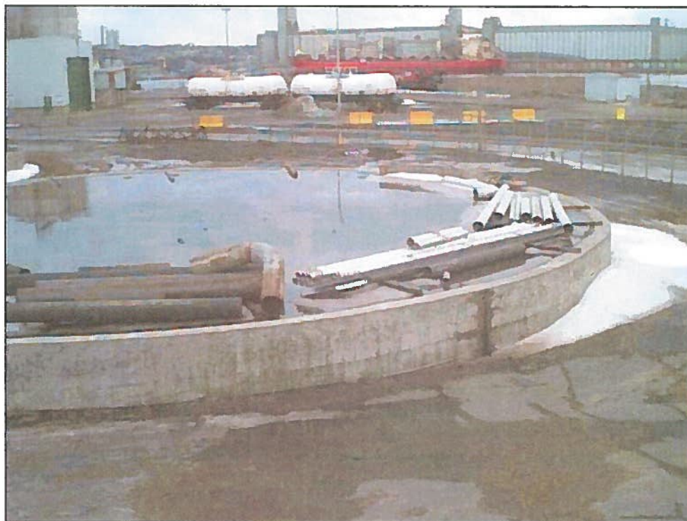
Photo 2. Des pièces d'équipement sont entreposées temporairement sur la base de béton
