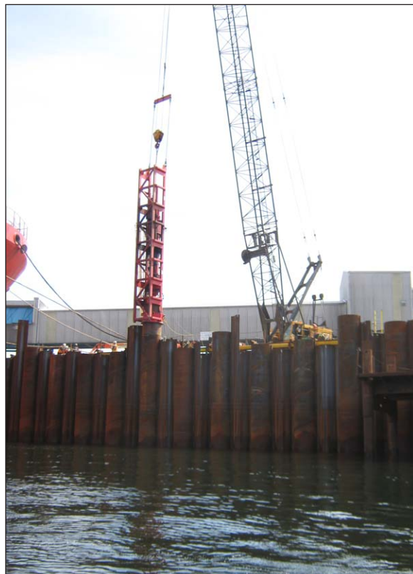
PHOTO 14 Activité de battage de pieu.
