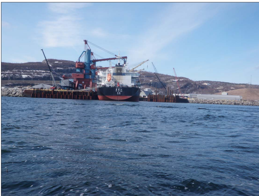
PHOTO 2 Vue partielle des quais en réfection.
