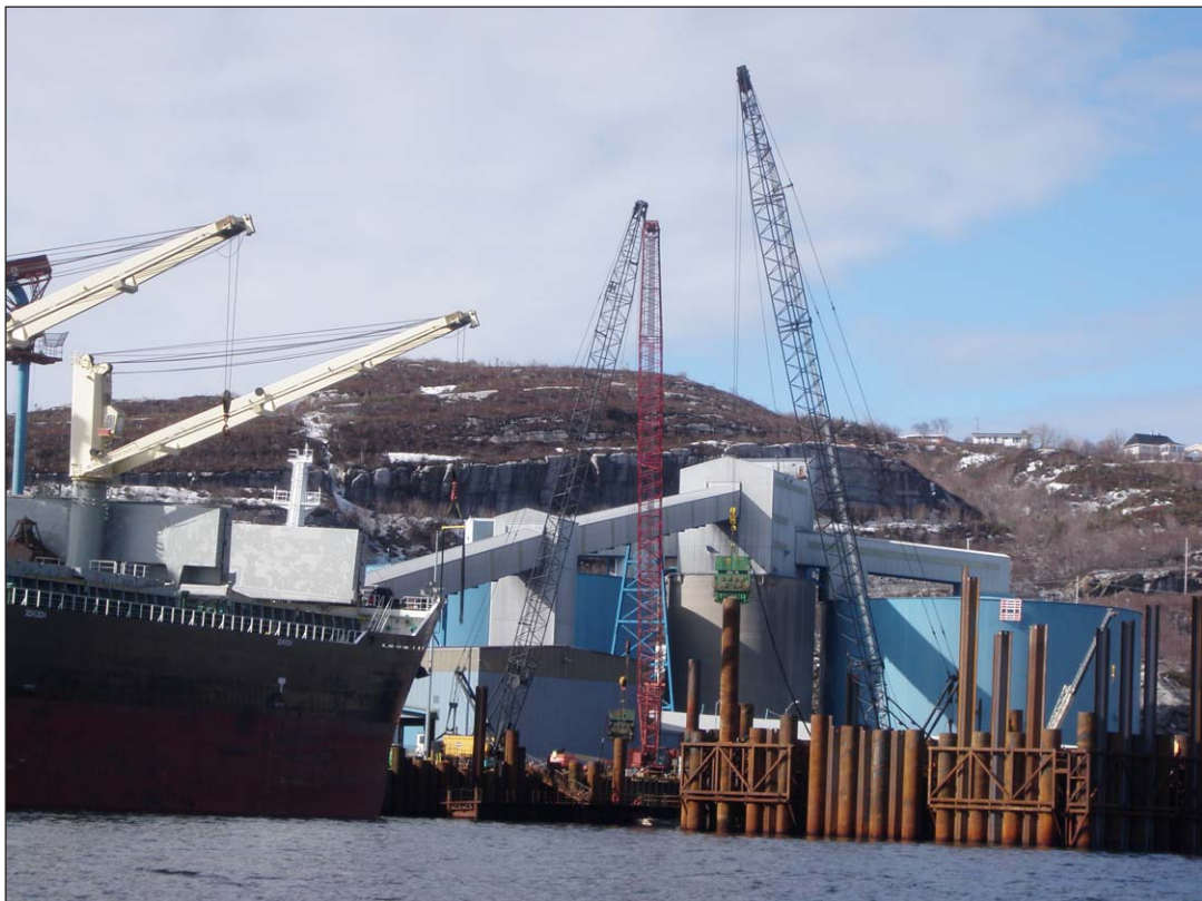
PHOTO 10 Activité de battage de pieu.
