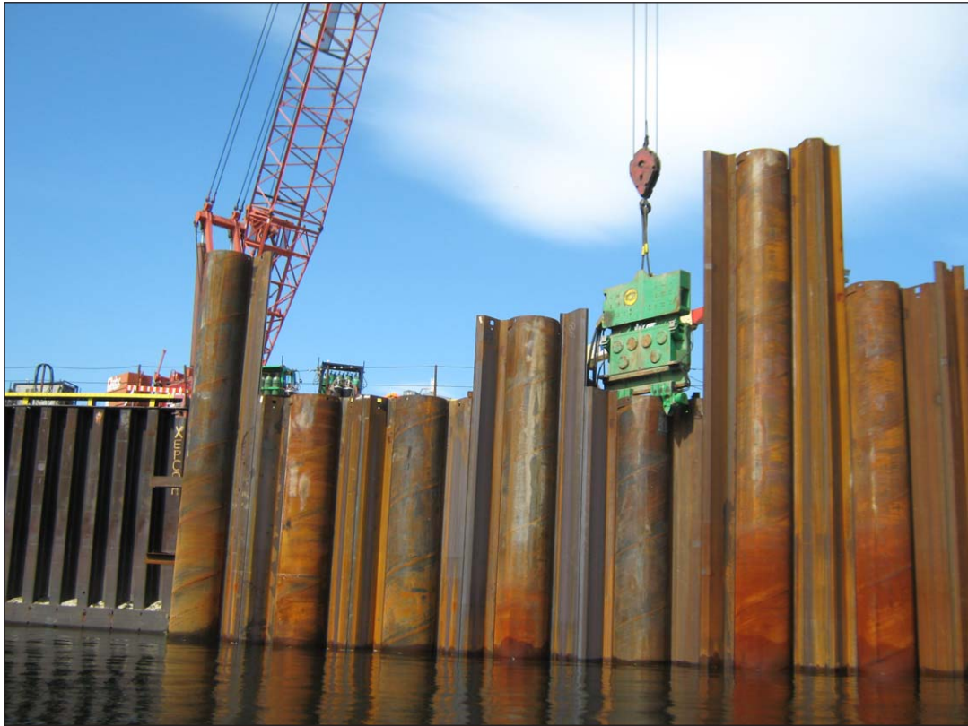
PHOTO 17 Vibrofonçage.
