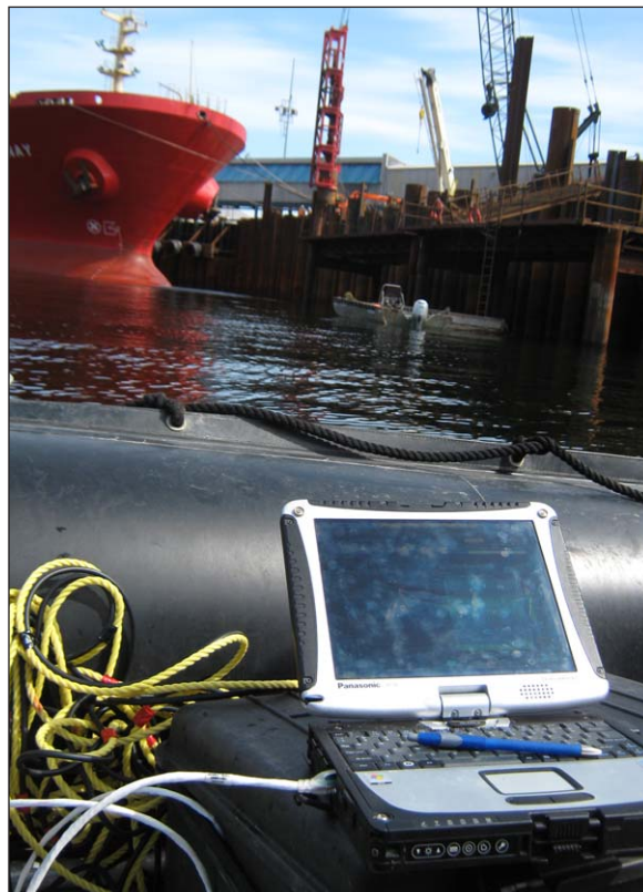
PHOTO 16 Prise de mesures pendant le battage de pieu.
