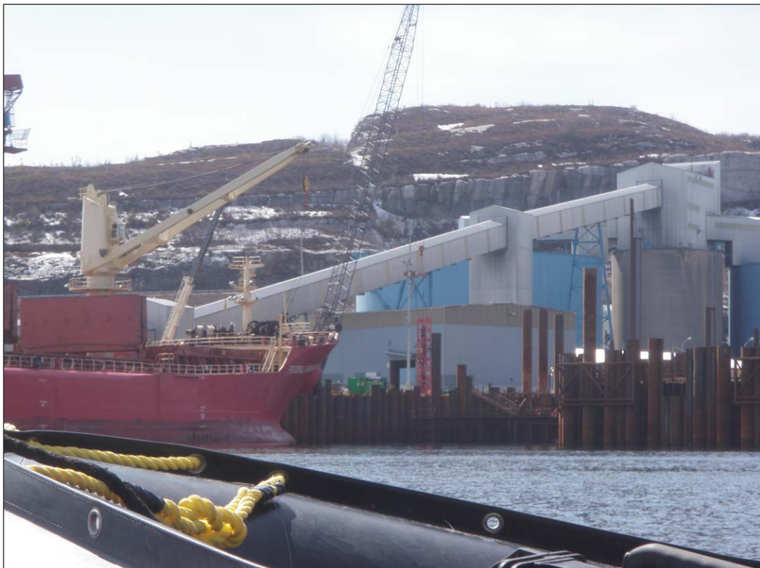
PHOTO 8 Activité de battage de pieu.
