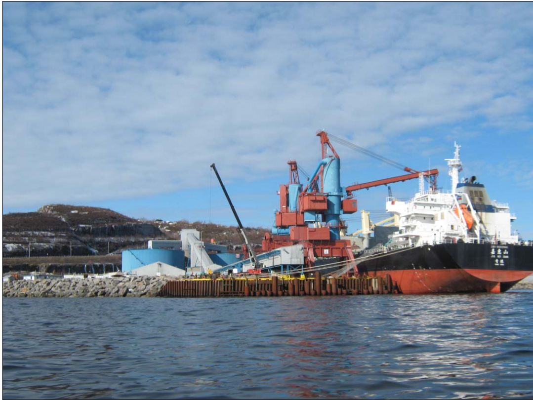
PHOTO 9 Déchargement de navire.
