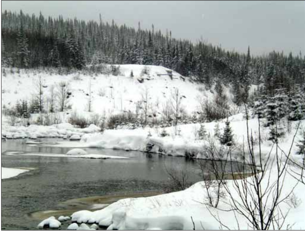
PHOTO 5 Vue du site de l'ancien barrage depuis l'amont.
