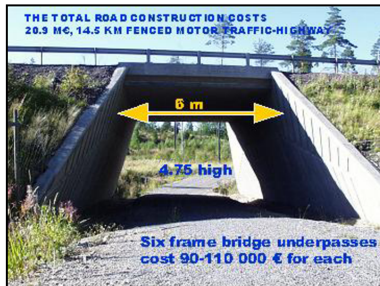
Photo 2 Petit ponceau pour l'original (Finlande)
