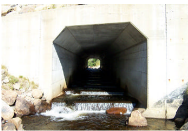
Seuils sous le pont de la rivière Cachée
