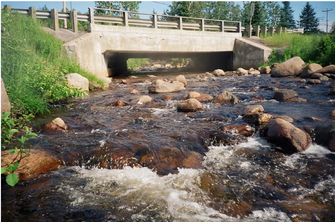
Photo 12 Le ruisseau Taché s'écoule en cascade sur substrat de blocs et galets au niveau de la route 175 (segment 24).
