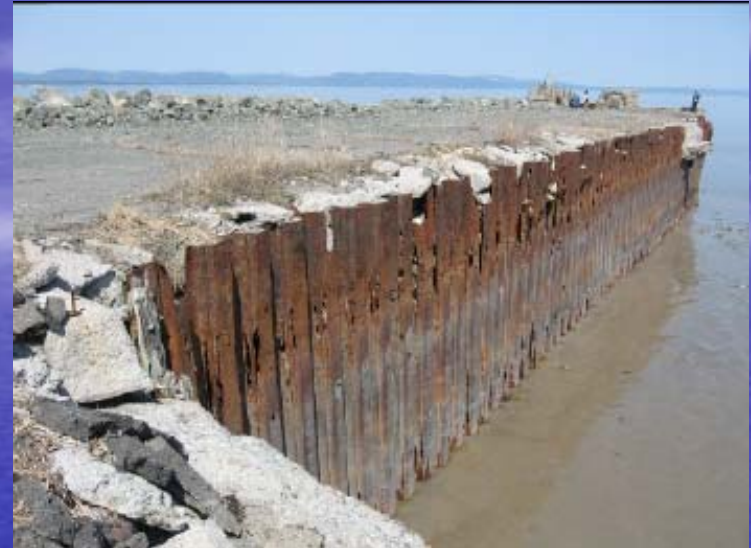
Côté nord du quai commercial (quai brise-lames)
