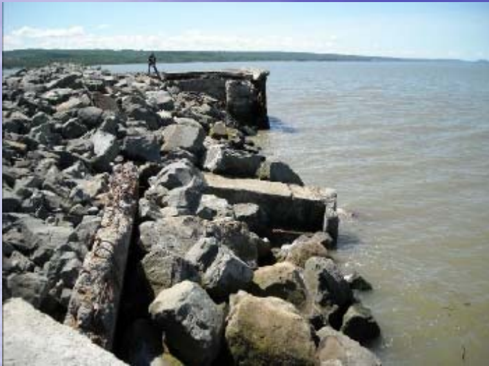
Tête du quai commercial (quai brise-lames)
