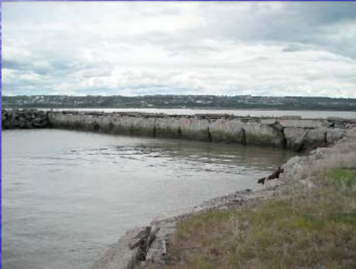
Côté sud du quai commercial (quai brise-lames)
