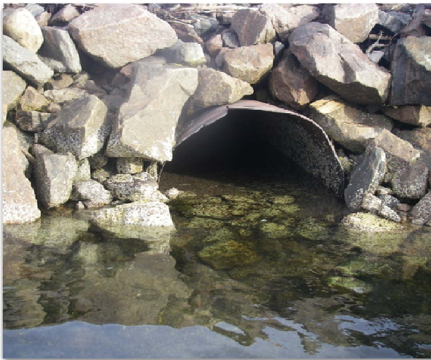
Photo 8 : Ponceau installé dans le tronçon 1
