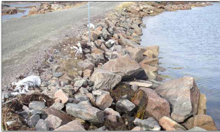
Photo 2 : Section représentative des rivages artificiels (remblais)
