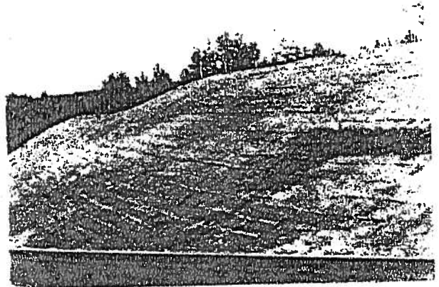
Stabilisation de talus. Méthode de plantation de boutures en gradins.
