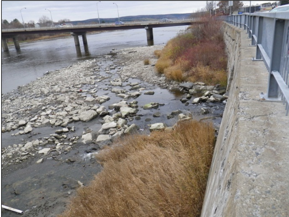
Photo 2 : Émissaire du ruisseau d'Ardoise dans la rivière Chaudière, 8 novembre 2012
