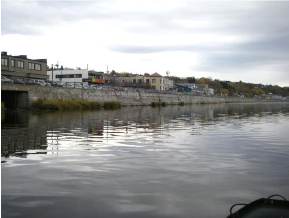
Photo 1 : Vue générale du quai Pinon
