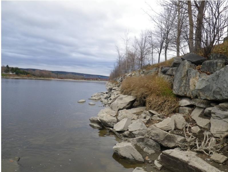
**Photo 5 :**      **Enrochement de stabilisation en rive droite, à l'aval du pont de la route 271, 8 novembre 2012**
