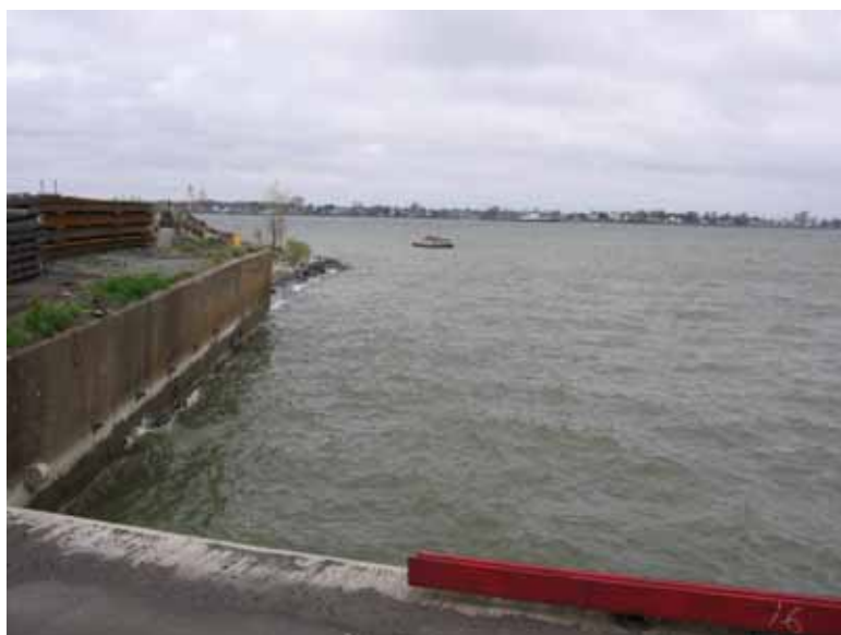
Photo 2.2 : Vue de l'extrémité nord (aval) du quai n°19 (2006)
