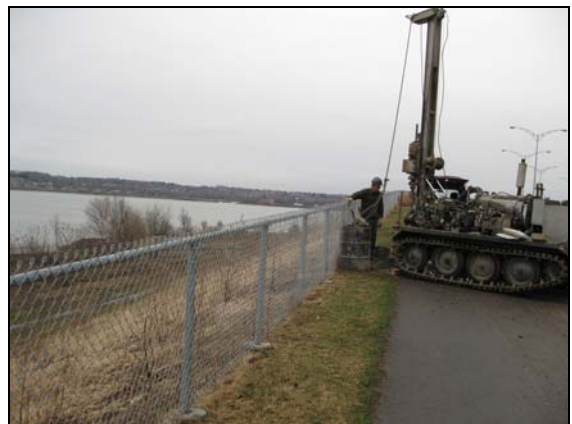
F27 dans le secteur du viaduc (vue vers le sud)
