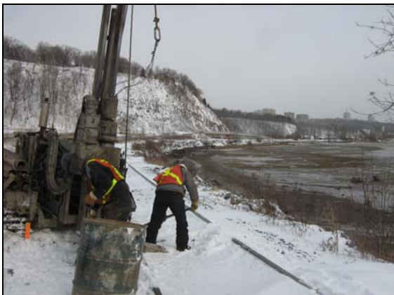
F8 en aval de l'ancien dépôt de Shell (vue vers le nord)
