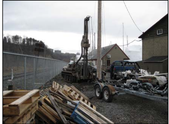
PO29 dans le secteur de la marina (vue vers le nord-est)
