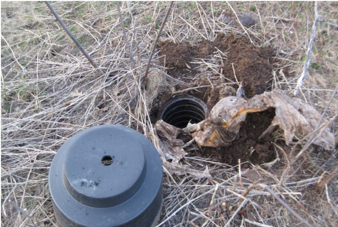
Photo 8 Développement et purge des puits (15 avril 2010) secteur du site de Shell.
