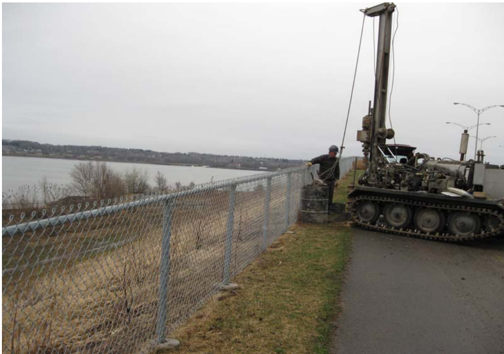
Photo 2 Réalisation du forage F27 (7 avril 2010) secteur du viaduc (vue vers le sud).
