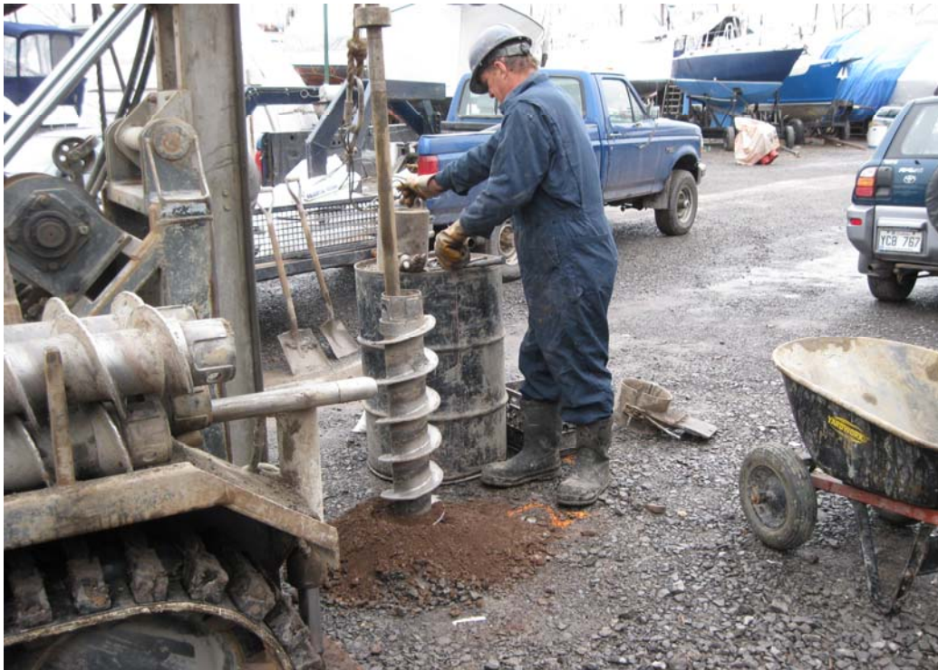
Photo 3 Réalisation du forage PO28 (7 avril 2010) secteur de la marina (vue vers le sud-est).
