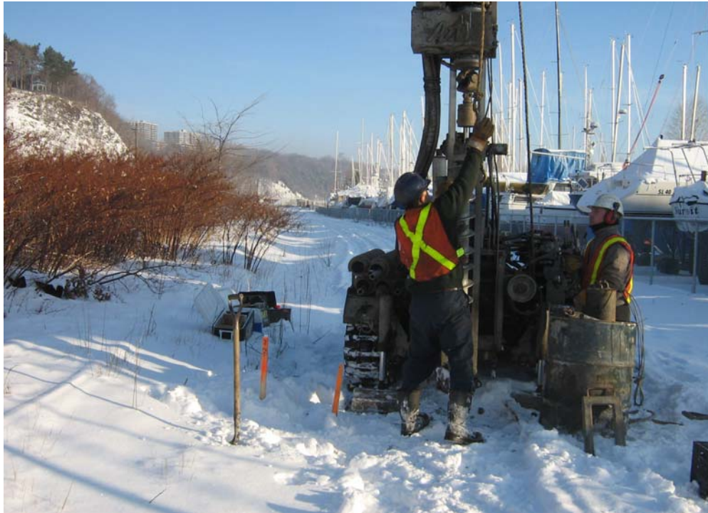
Photo 5 Réalisation du forage F15 (14 décembre 2009) en aval de l'ancien dépôt de Esso, à proximité de la marina (vue vers le nord-est).
