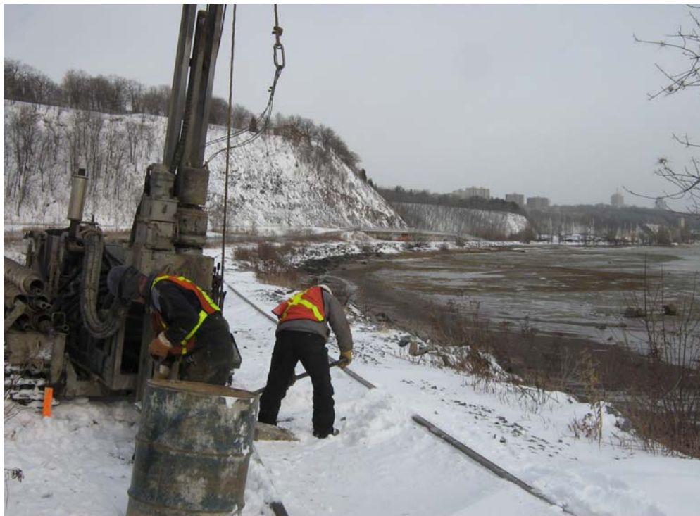
Photo 4 Réalisation du forage F8 (11 décembre 2009) en aval de l'ancien dépôt de Shell (vue vers le nord).
