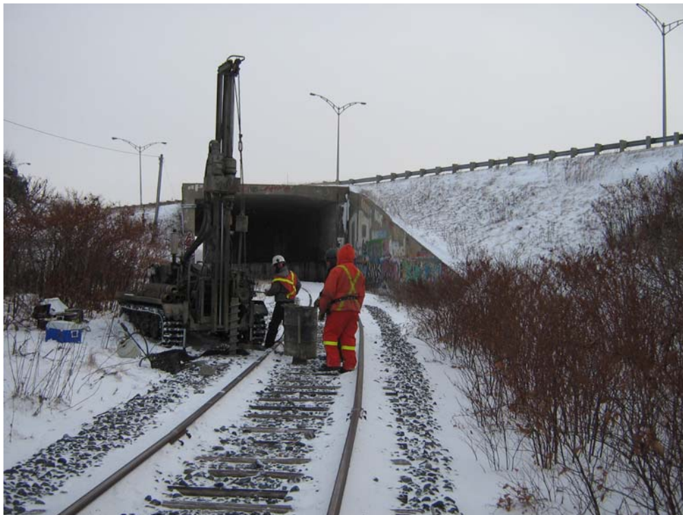
Photo 2 Réalisation du forage F5 (11 décembre 2009) près du tunnel ferroviaire (vue vers le sud).
