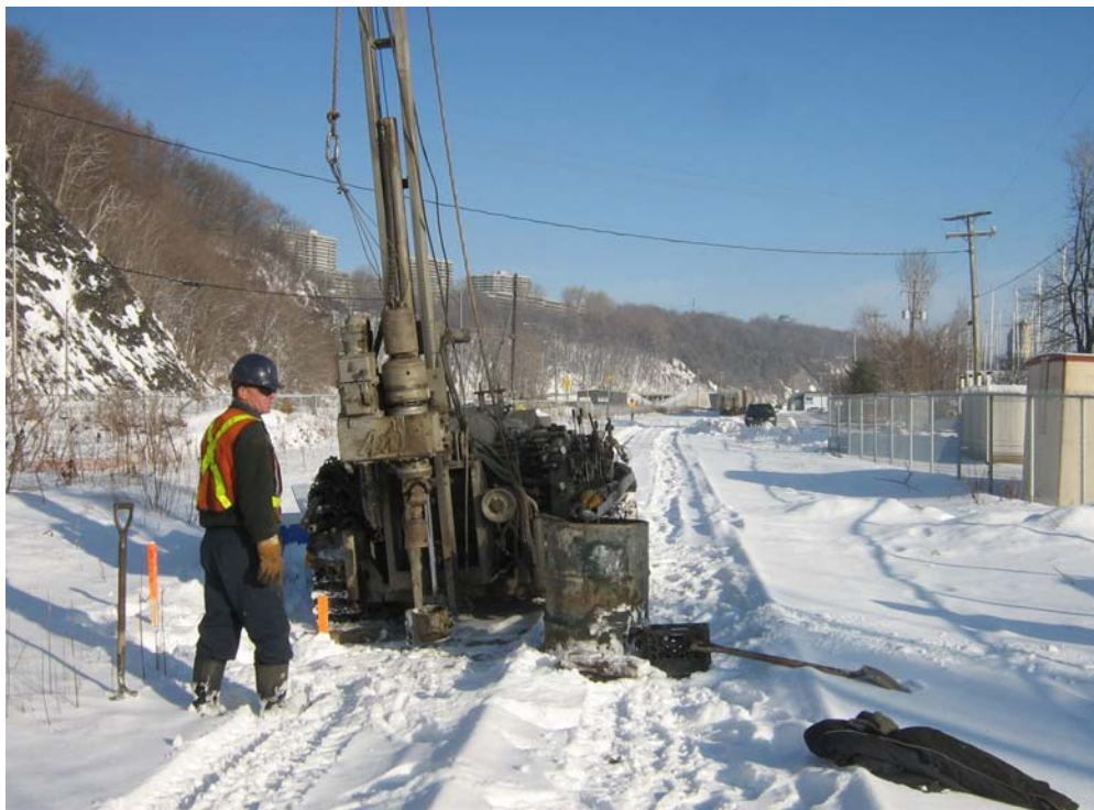
Photo 6 Réalisation du forage F17 (14 décembre 2009) en aval de l'ancien dépôt de Ultramar, à proximité de la marina (vue vers le nord-est).
