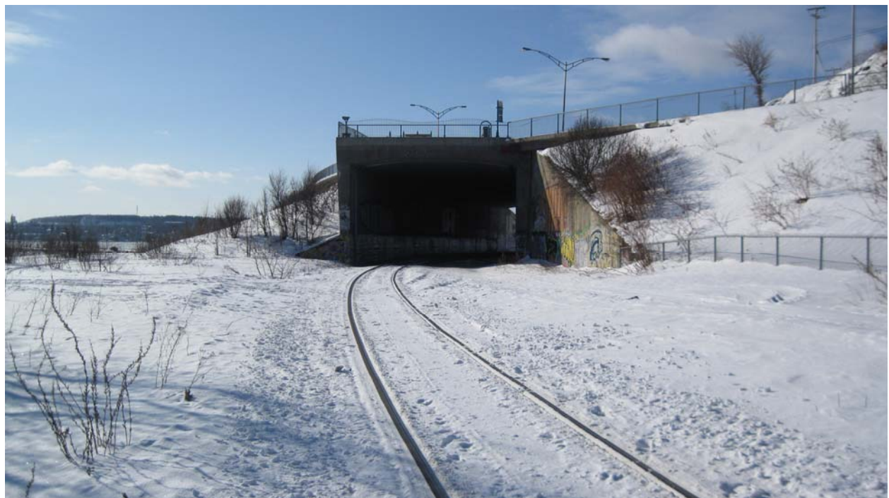
Photo 13 Tunnel ferroviaire (section 3). Vue vers le sud.
