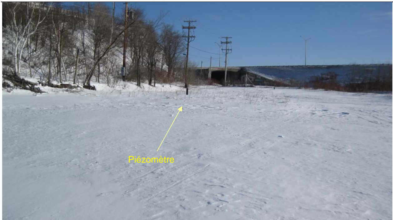
Photo 12 Ancien dépôt pétrolier de Pétro-Canada (section1). Vue vers le nord-est.
