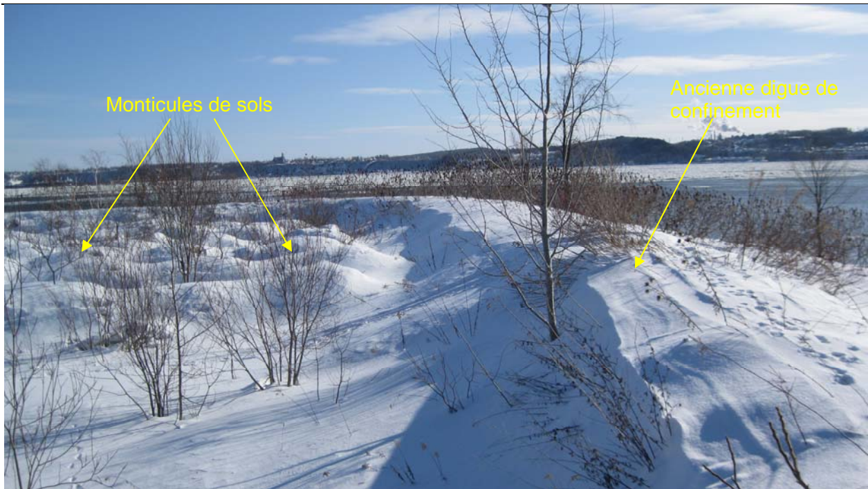
Photo 14 Prolongement de la section 3 avec digue de confinement (terrains de Shell). Vue vers l'est.
