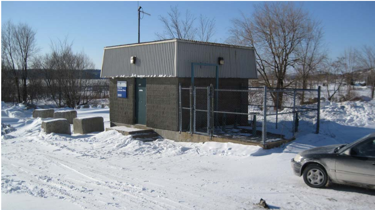
Photo 10a Station de pompage, Ville de Québec (section 1).
