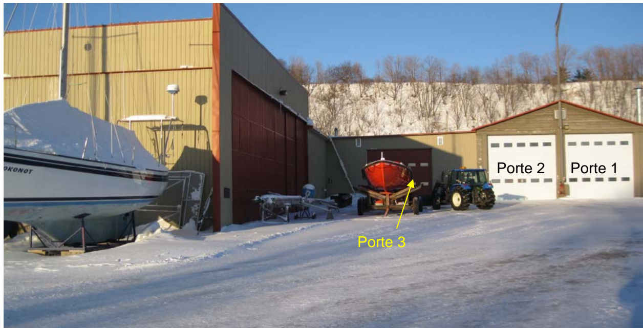
Photo 5a Bâtiment de Boulet, Lemelin Yacht : portes 1, 2 et 3. Vue vers l'ouest.
