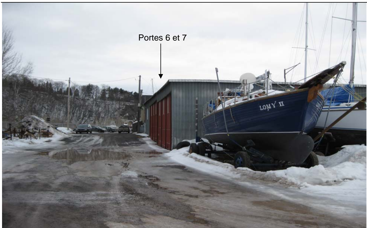
Photo 4a Vue du bâtiment (remisage de bateaux), portes 6 et 7.
