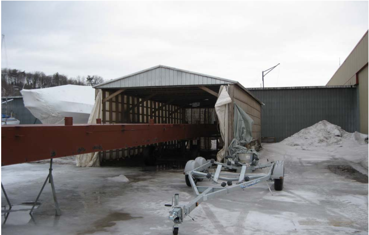
Photo 2a Abri temporaire pour le sable par jet. Boulet, Lemelin Yacht inc. (Marina).
