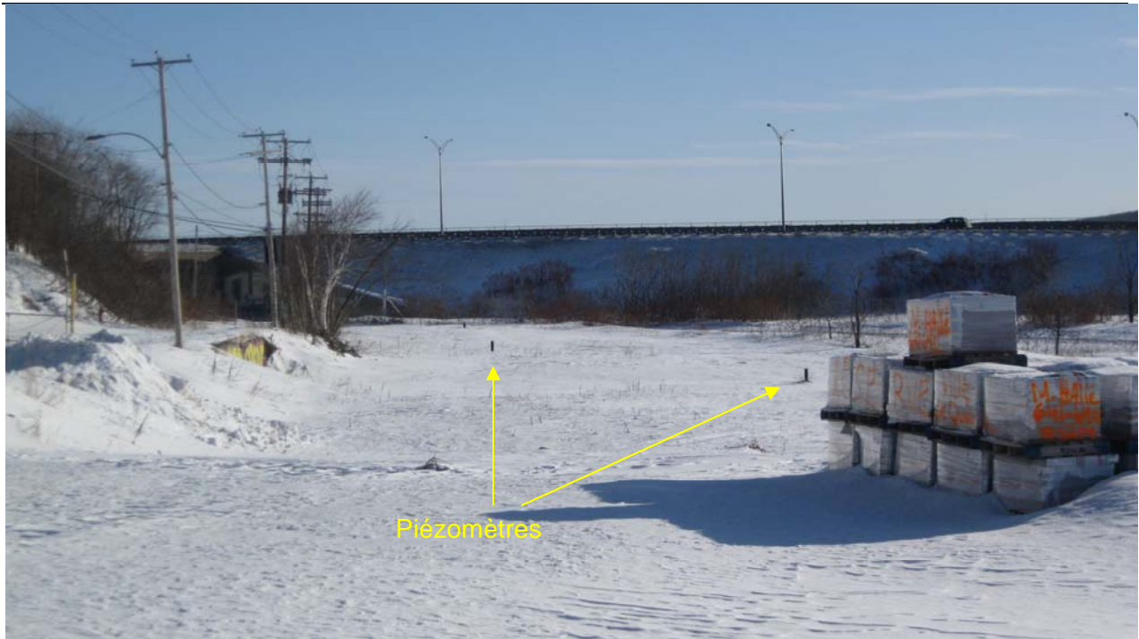
Photo 10c Ancien dépôt pétrolier de Pétro-Canada (section1). Vue vers le sud-est.
