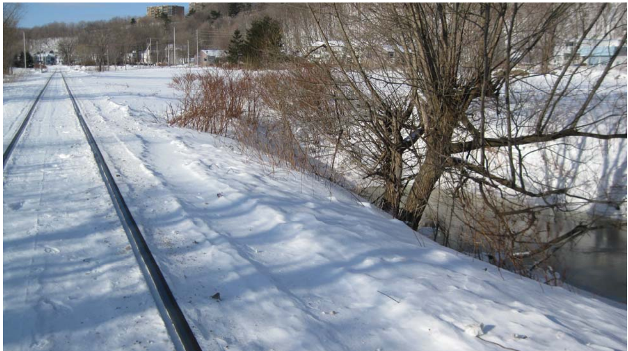
Photo 11 Accumulation d'eau en bordure de la voie ferrée (section 1). Vue vers l'ouest.
