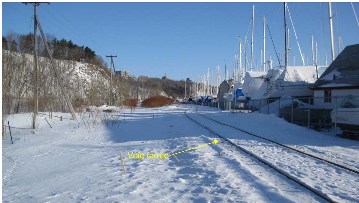
Photo 7c Ancien dépôt de Esso (section 4). Vue vers le nord-est.
