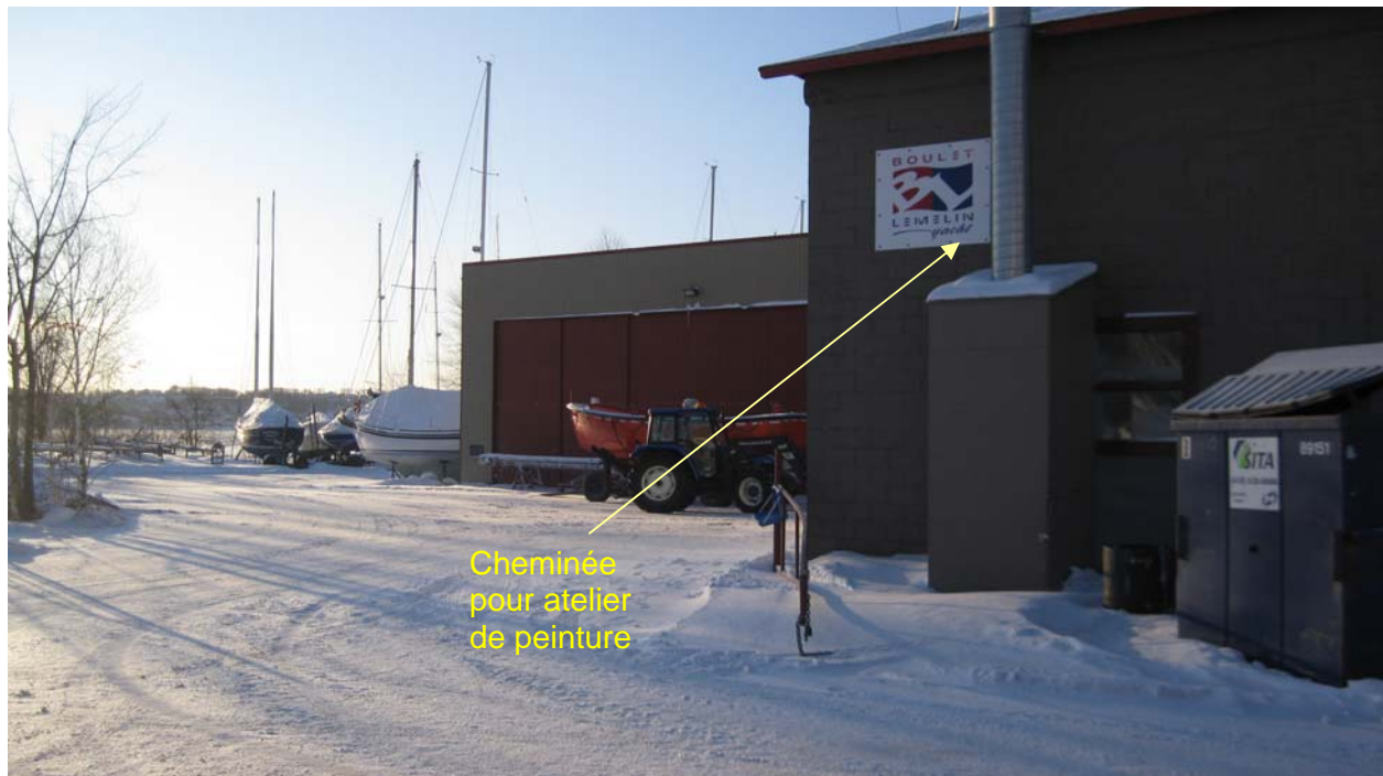
Photo 1a Vue vers le sud-est des bâtiments de Boulet, Lemelin Yacht inc, (Marina).
