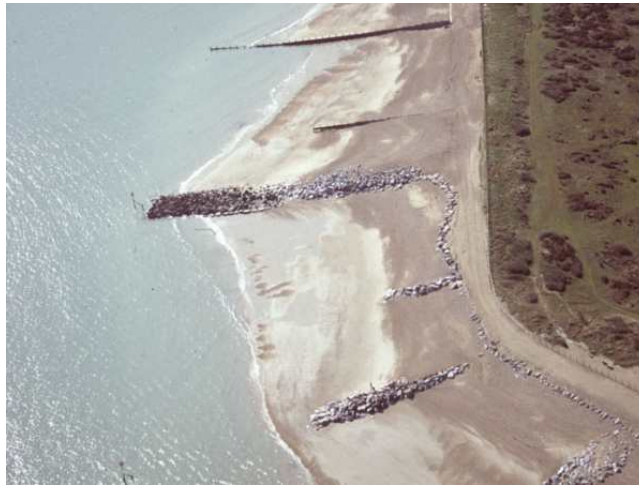
Exemple d'épi en enrochement
