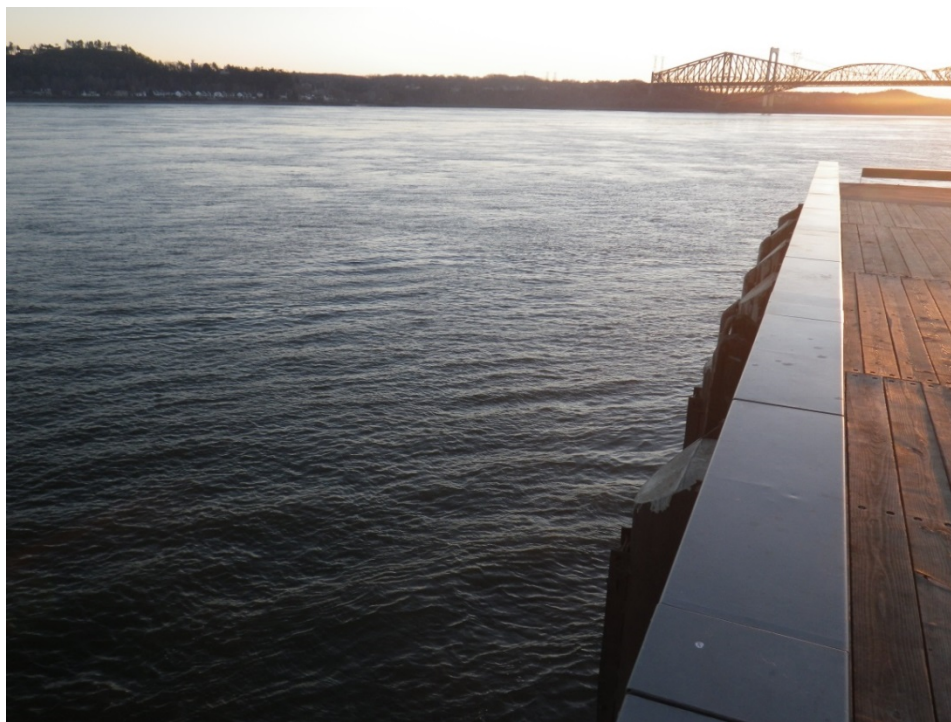
Quai des Cageux, 17 novembre 2011. La partie en front du fleuve mesure 18 mètres et son tirant d'eau dépasse toujours 2 mètres. Au loin, à 1,6 km, la marina de la Chaudière.
