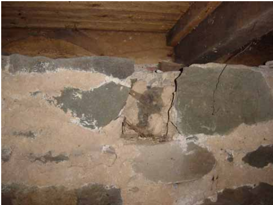
Figure 4 : Encavure des poutres de la première maison (no 1685)
