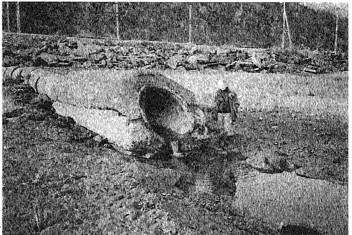
L'émissaire déstabilisateur de 48" de diamètre
