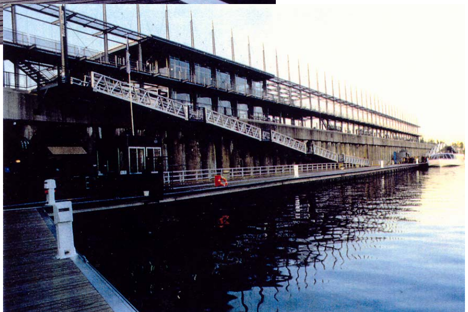
Photo #18 Passerelles, Vieux-Port de Montréal
