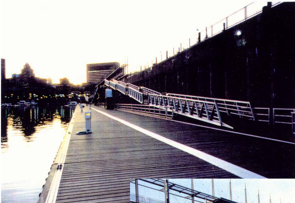
Photo #17 Passerelles, Vieux-Port de Montréal
