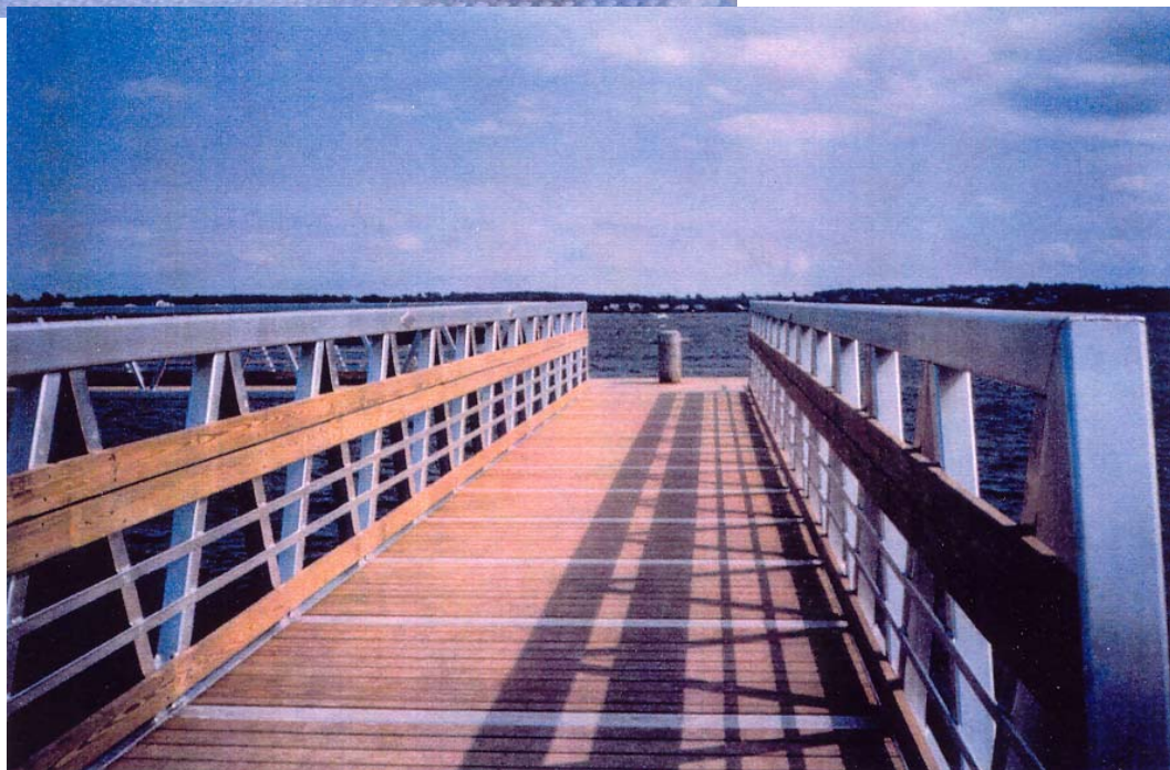
Photo #15 Passerelle d'aluminium, platelage en bois traité
