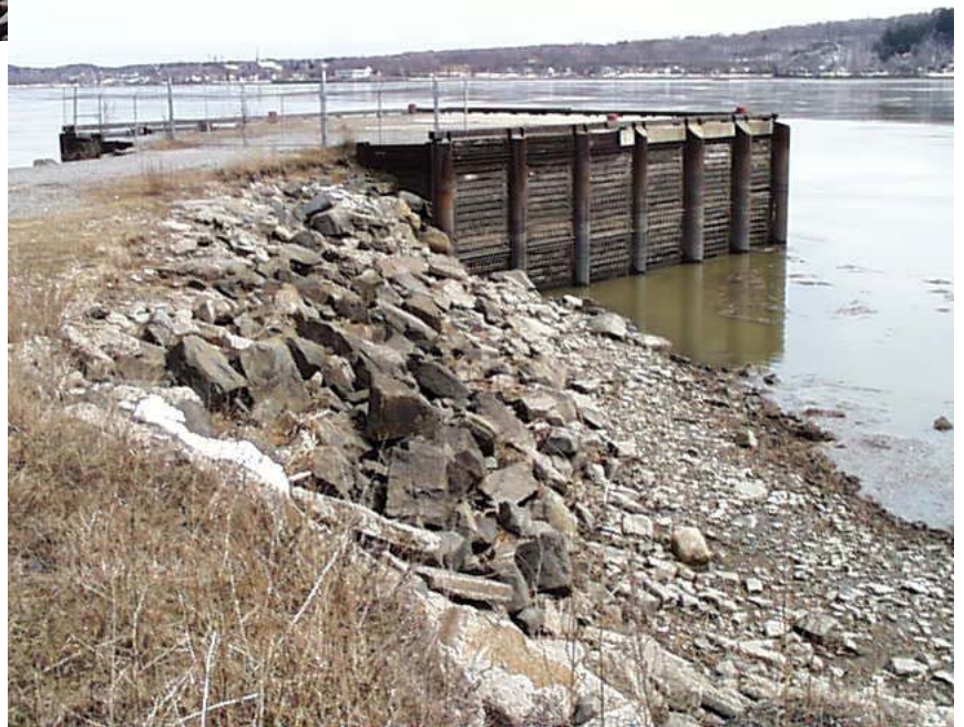
Photo #5 Quai Irving, face ouest, marée basse
