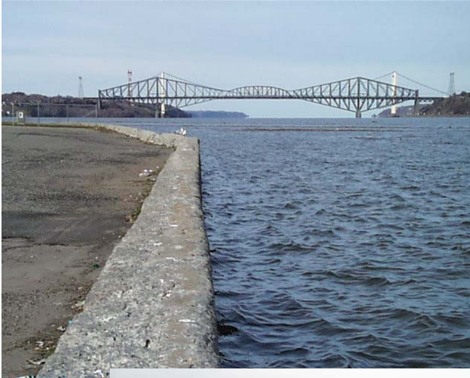
Photo #7 Usine de filtration, Lévis marée haute
