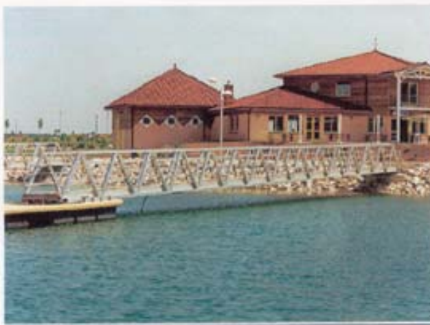
Photo #16 Passerelle d'aluminium, platelage de polypropylène antidérapant
