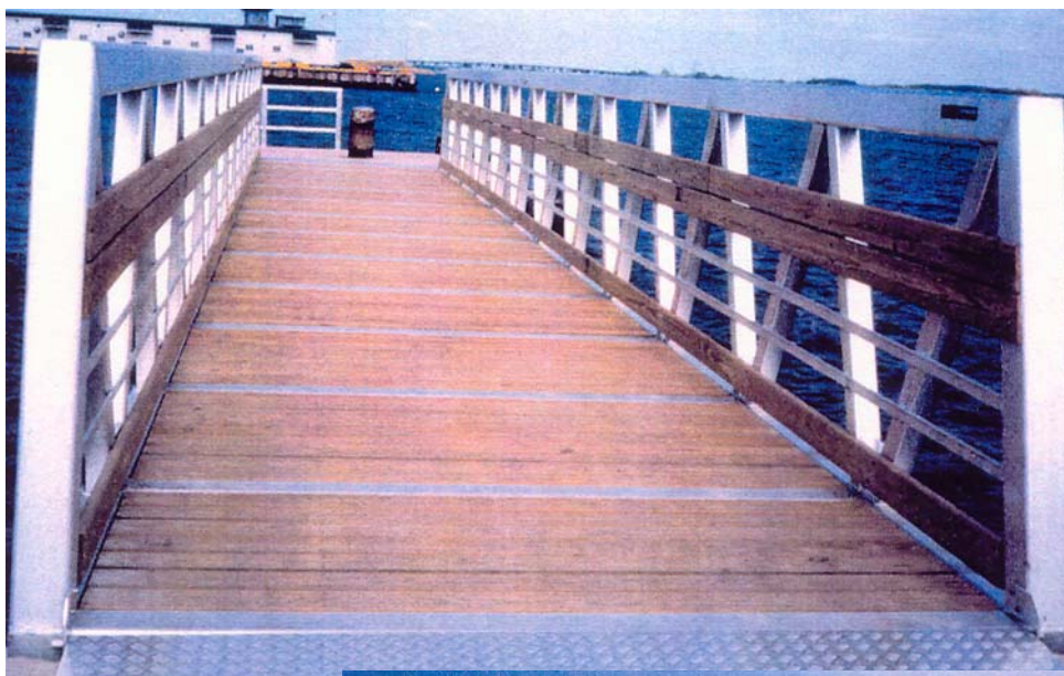
Photo #14 Passerelle d'aluminium, platelage en bois traité
