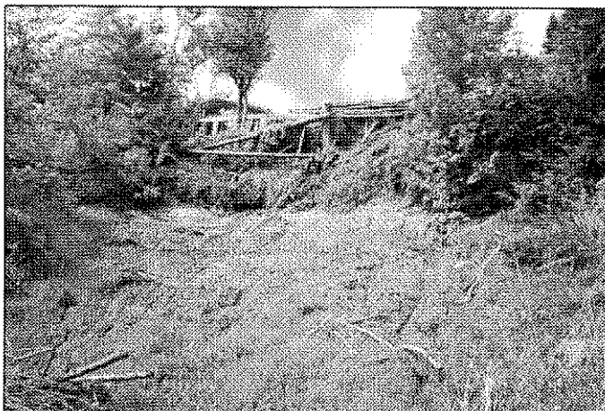
Photo 3 : Effondrement suite au déboisement d'une section de berge de la rivière Saint-François, région de Drummondville, 2001.
