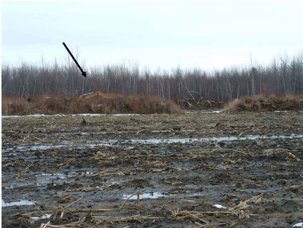
Déboisement d'une friche à l'aide d'une pelle mécanique. MRC Les Maskoutains
