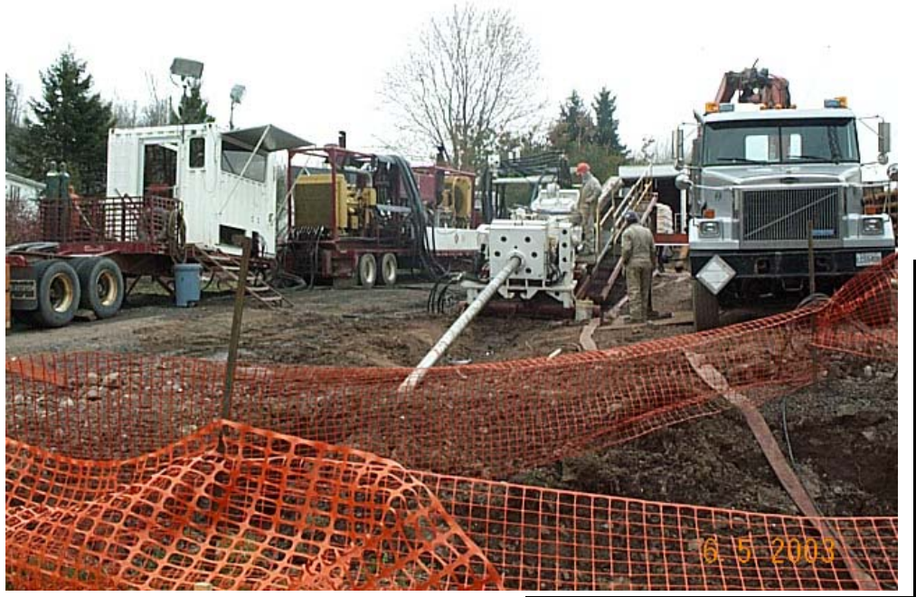
Photo n° 13. Exemple de chantier pour la variante du forage directionnel (l'emplacement prévu pour ce chantier se trouve sur le stationnement existant; photo n° 9).
