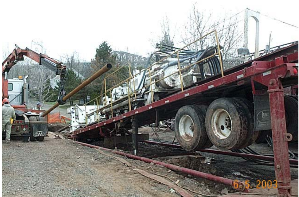
Photo n° 10. Exemple de mobilisation du chantier pour la variante du forage directionnel.
