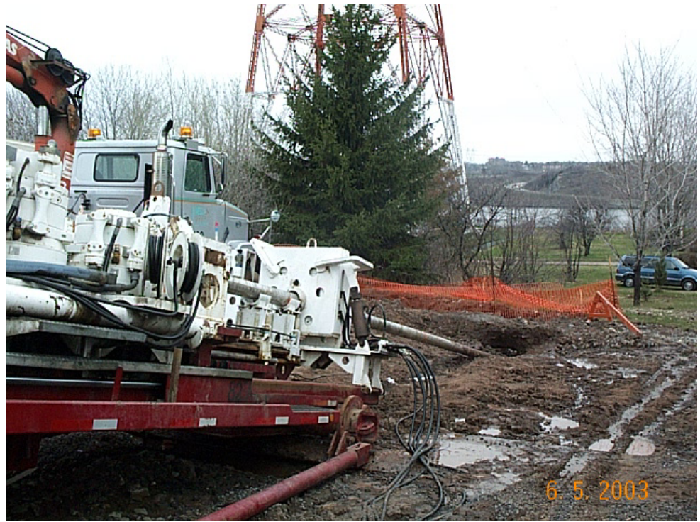
Photo n° 11. Forage directionnel.
