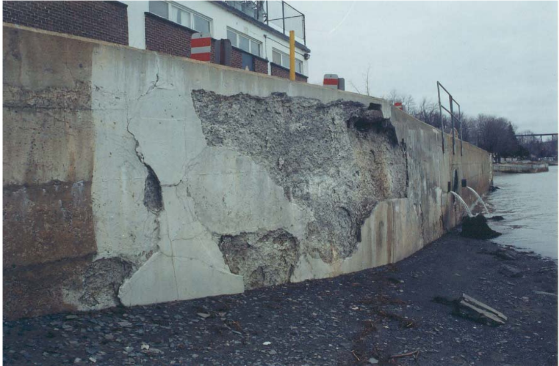
Photo n° 9. État du mur de soutènement en avril 2005.
