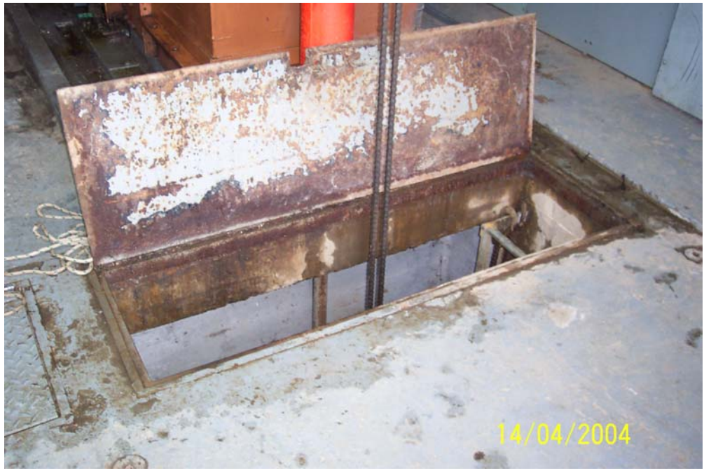
Photo n° 1. Ouverture dans le plancher donnant accès au puits.
