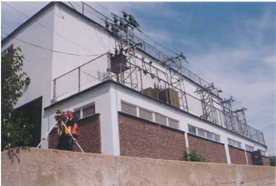
Photo n° 31. Positionnement des stations 450 et 617 (28 juillet 2004).
