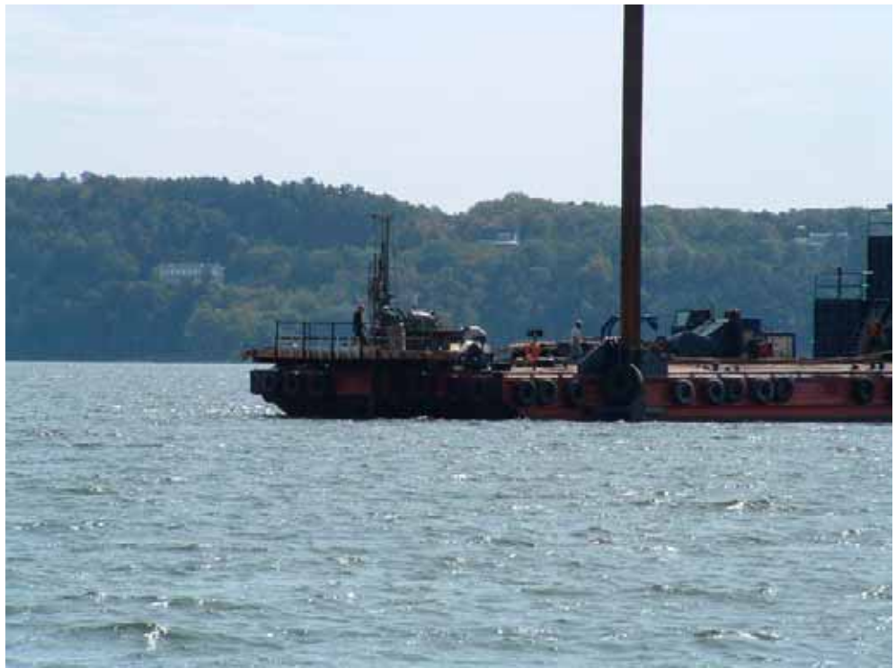
Photo n° 42. Vue rapprochée de la foreuse se trouvant sur la barge du LEQ
