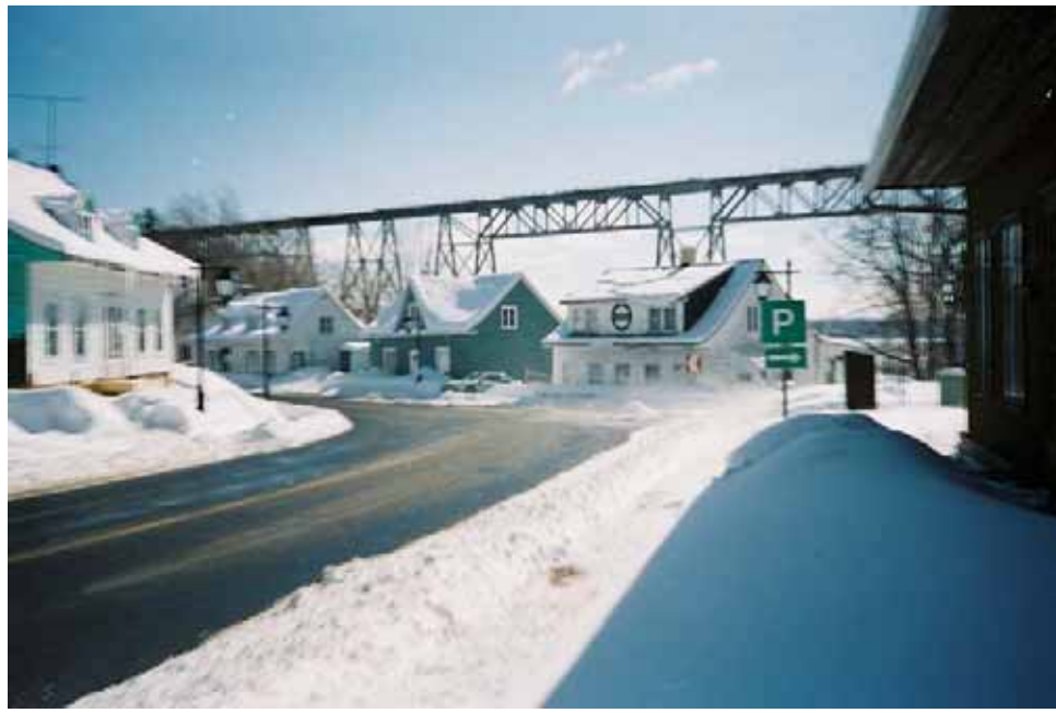
Photo n° 48. Vue de la rue Provencher dans le Vieux Cap-Rouge.
