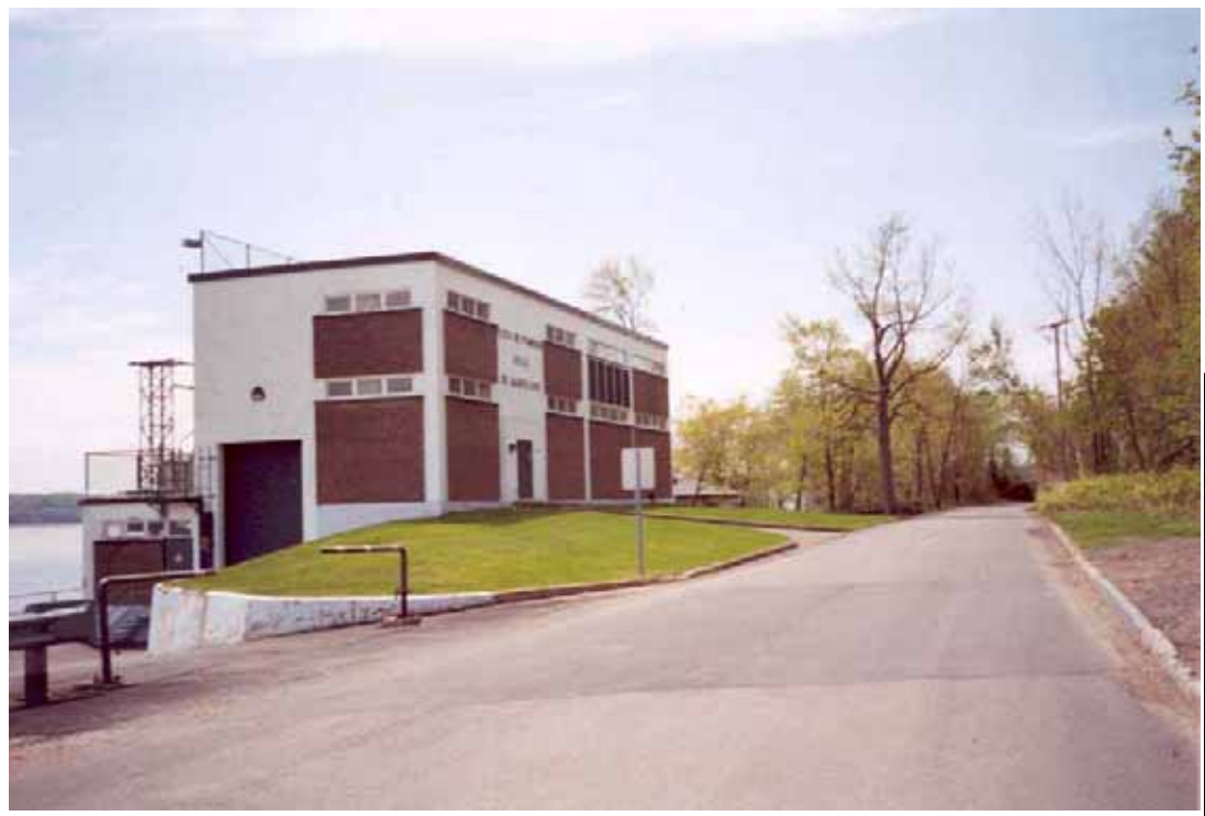
Photo n° 50. Vue de la station de pompage d'eau brute de Sainte-Foy à partir de la rue de la Plage-Saint-Laurent
