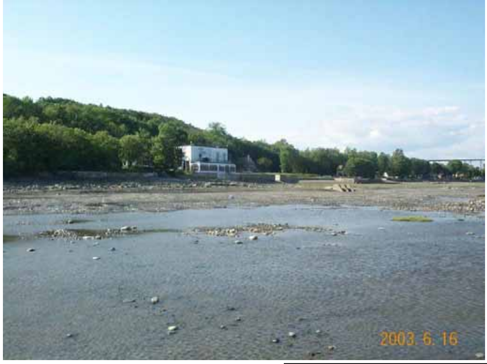
Photo n° 1. Vue d'ensemble, à marée basse, de l'aire des travaux projetés
