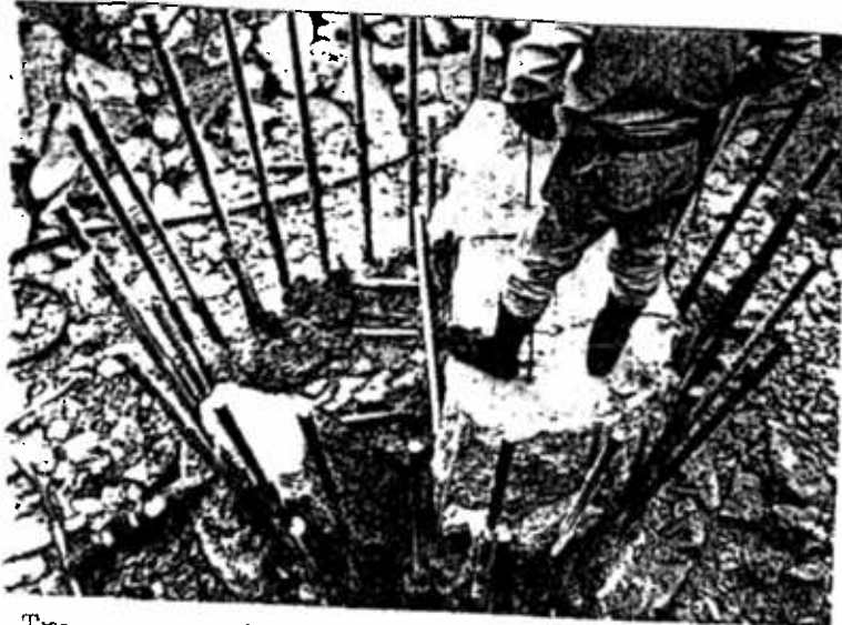
Travaux de démontage
