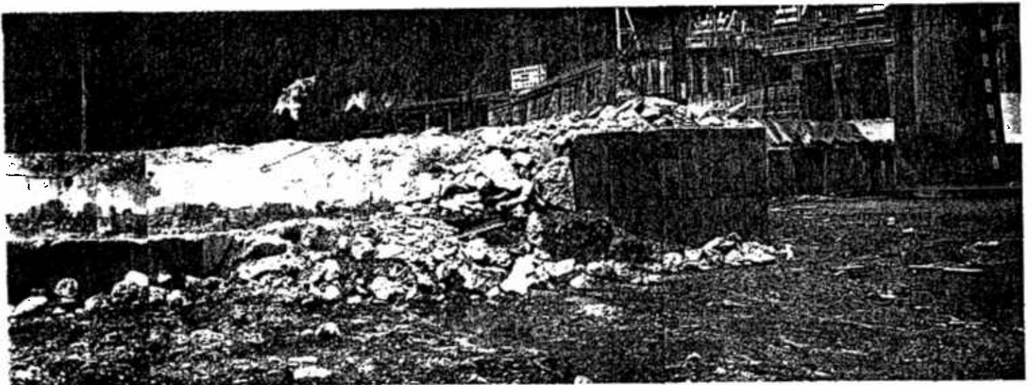
Vue du mur démoli.
