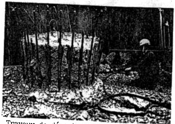
Travaux de démontage
