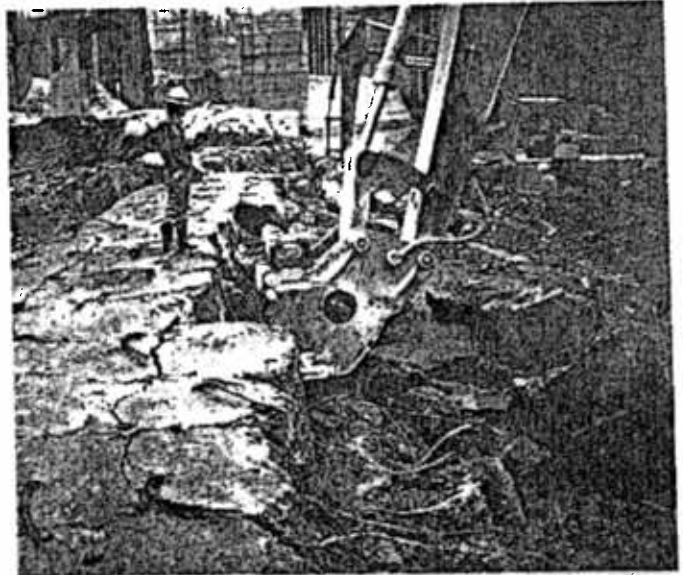
Rupture secondaire accélérée par marteau lourd
