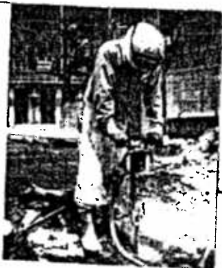
Forage avec petite foreuse pneumatique
