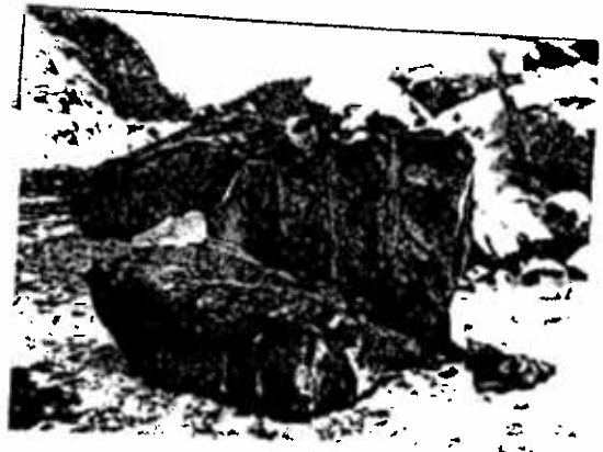
Démolition des galets
