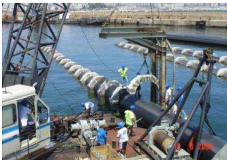
Figure 2.3 - Mise en place des blocs de lestage sur la partie terrestre
