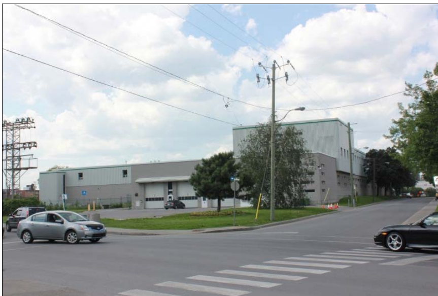
Figure 5 Usine de production d'eau potable Lachine
