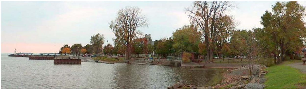
Figure 11 Berges au droit du parc Saint-Louis
