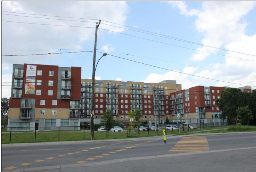
Figure 4 Résidence pour personnes retraitées (vue côté nord de la rue Notre-Dame)
