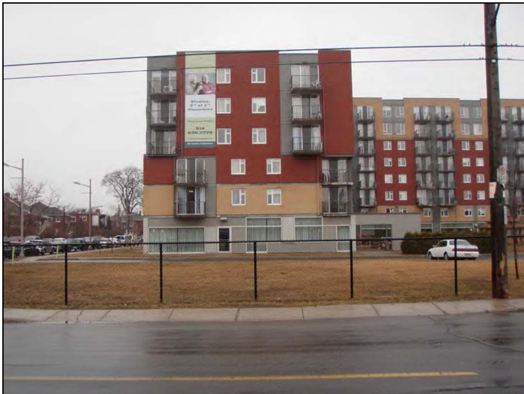
Photo 2 : Secteur d'excavation B devant l'aile ouest du complexe immobilier Les Belvédères de Lachine, vue vers le nord (photo Martin Royer)
