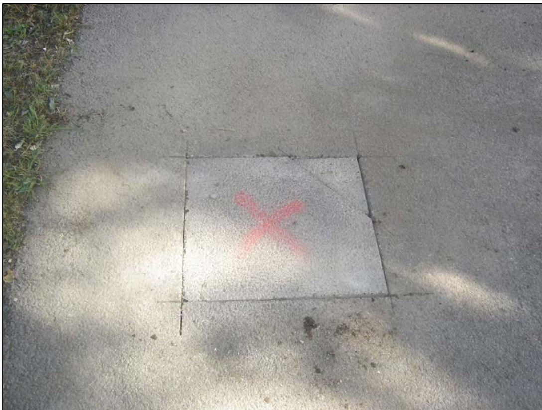
Photo 7 – Forage F-02 en fin de travaux
