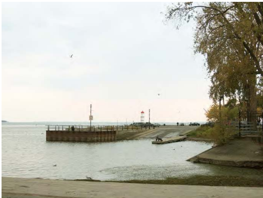
Figure 3-14 Quai et rampe de mise à l'eau
