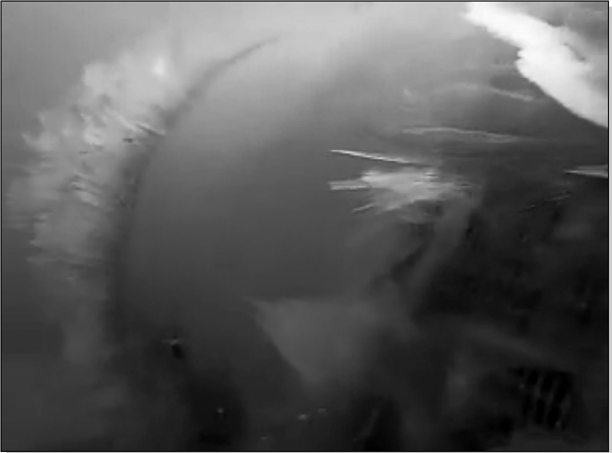
Photo 4 :Prise d'eau colmatée par le frasil
