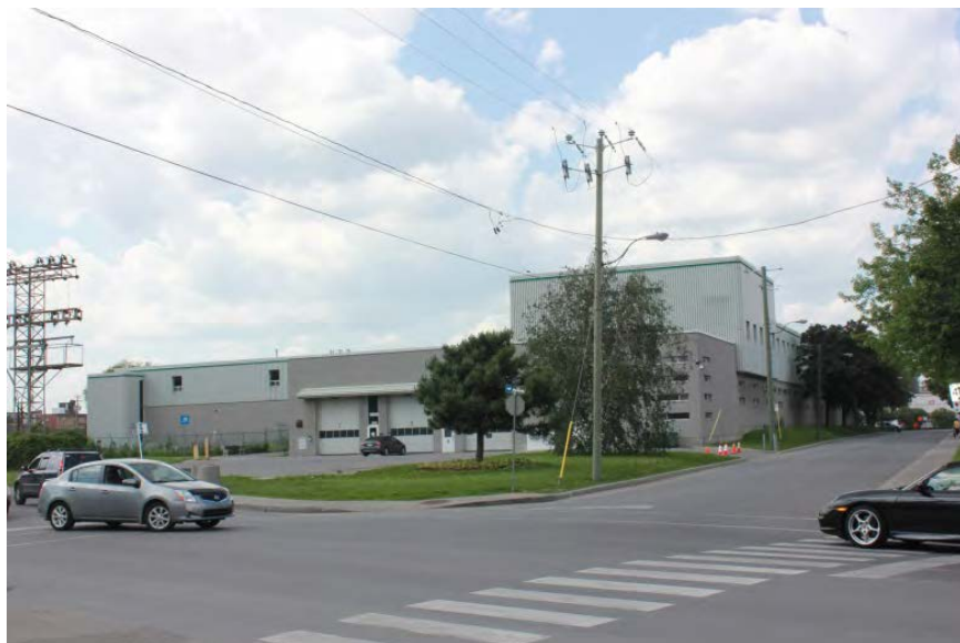
Figure 3-2 Usine de production d'eau potable Lachine
