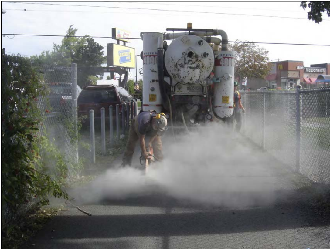
Photo 3 – Forage F-02, sciage de la surface asphaltée de la piste cyclable, au sud de la rue Victoria
