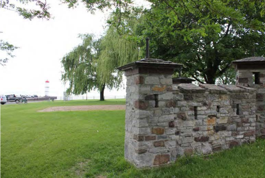
Figure 3-12 Vestige du Fort Rolland (vue en direction sud-est)
