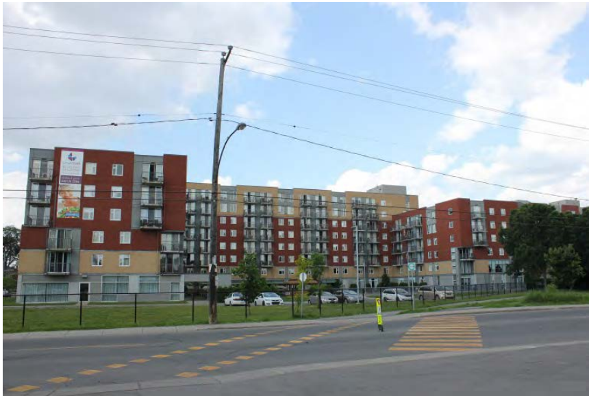
Figure 3-7 Résidence pour retraités, sur le côté nord de la rue Notre-Dame
