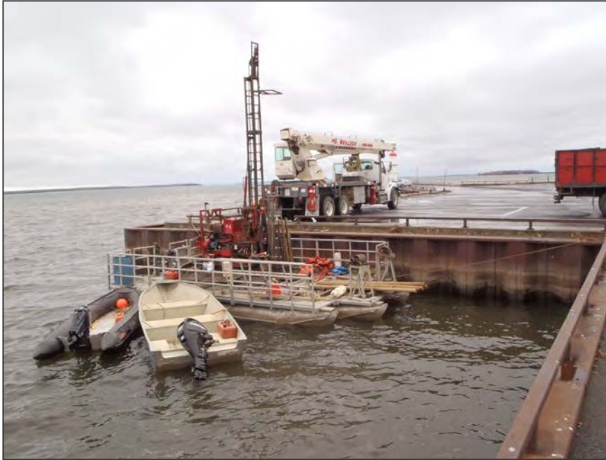
Figure 1. Foreuse CME-55 montée sur barge.
