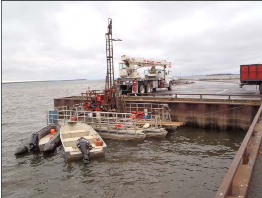
Figure 1. Foreuse CME-55 montée sur barge.
