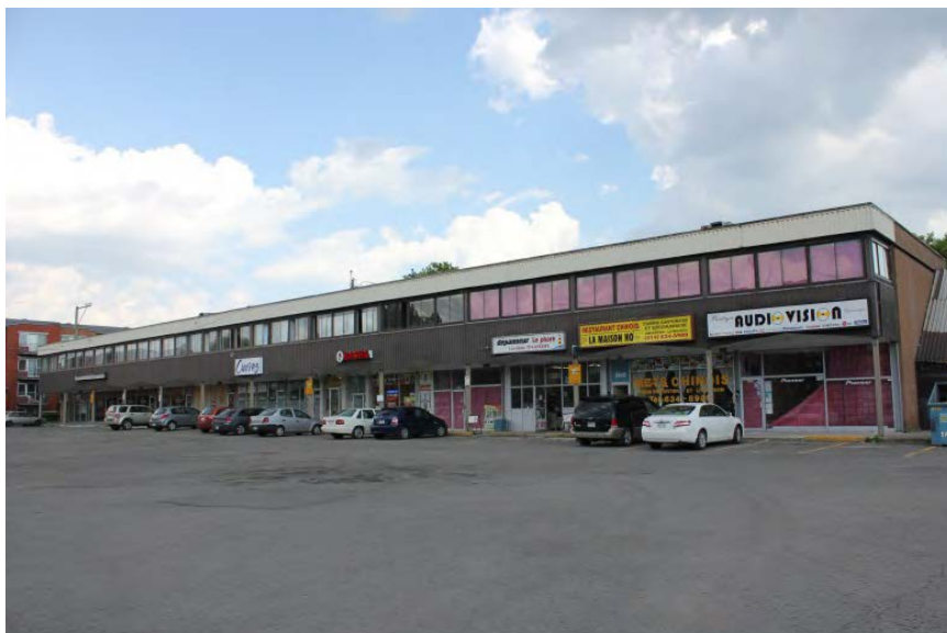
Figure 3-8 Bâtiment commercial, sur le côté sud de la rue Notre-Dame
