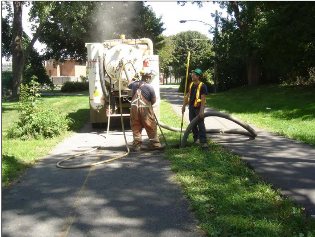
Photo 10 – Réalisation du forage F-05, en bordure de la piste cyclable, à mi-distance entre les forages F-02 et F-03
