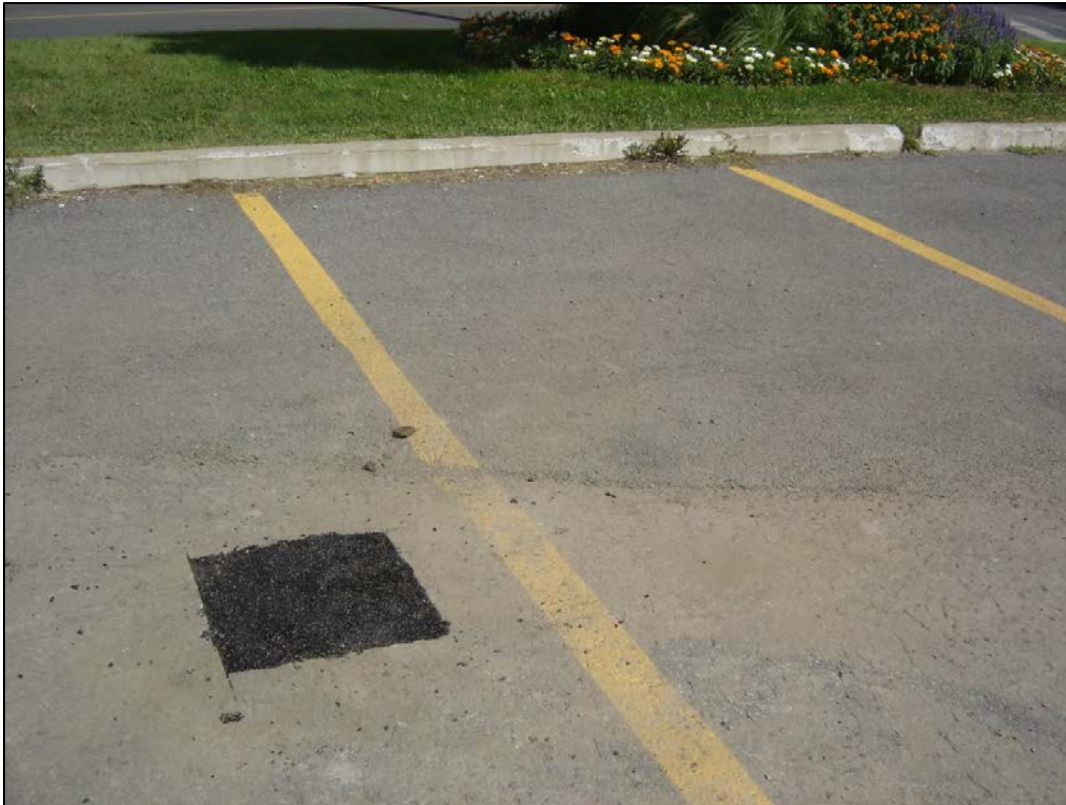
Photo 2 – Forage F-01, en fin de travaux, refermé avec de l'asphalte froide
