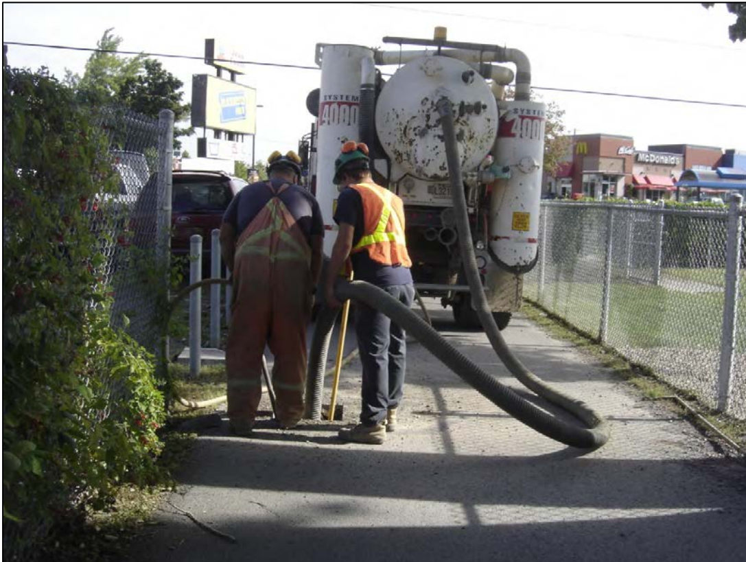
Photo 4 – Réalisation du forage F-02
