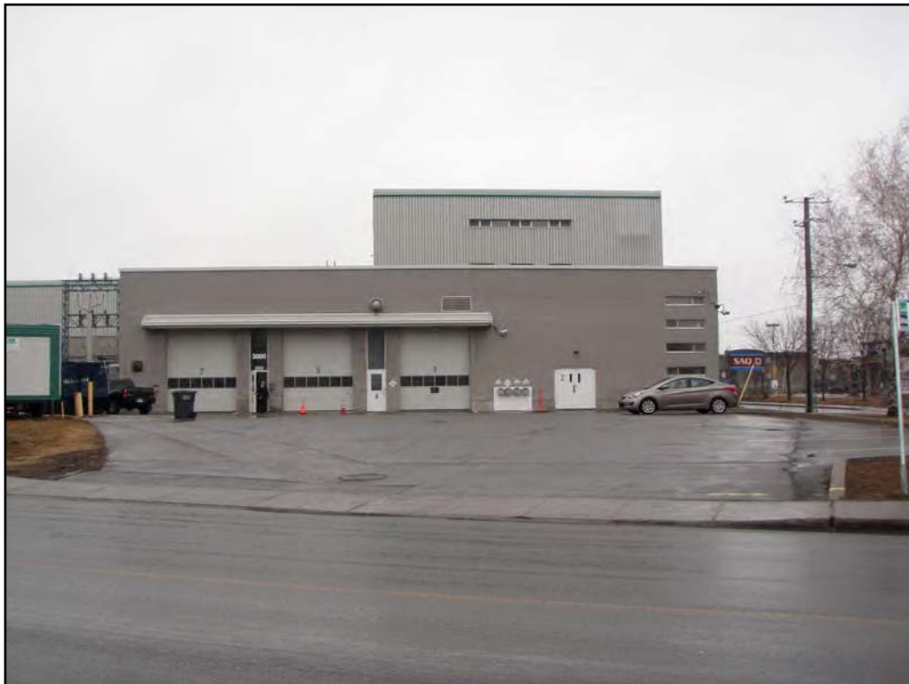
Photo 4 : Secteur d'excavation D à l'arrière de l'usine de filtration, vue vers le nord (photo Martin Royer)
