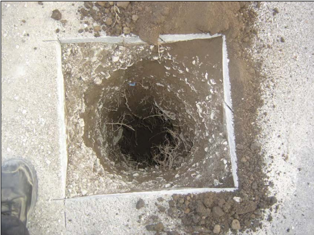
Photo 6 – Vue de l'intérieur du forage F-02
