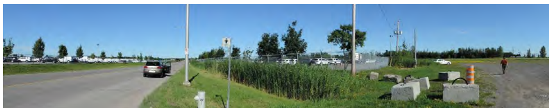
Photo 4-6 : Paysage urbain U3 – Vue ouverte sur les aires de stationnement et d'entreposage du parc industriel de Saint-Eustache
