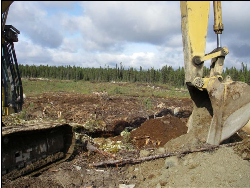
Photo 1 Travaux d'excavation effectués à l'aide d'une pelle hydraulique de la tranchée TR-113.
