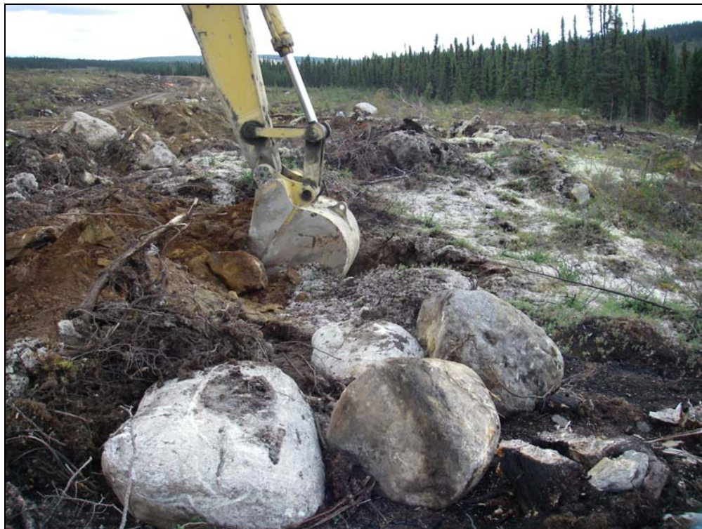
Photo 4 Travaux d'excavation effectués à l'aide d'une pelle hydraulique de la tranchée TR-134.
