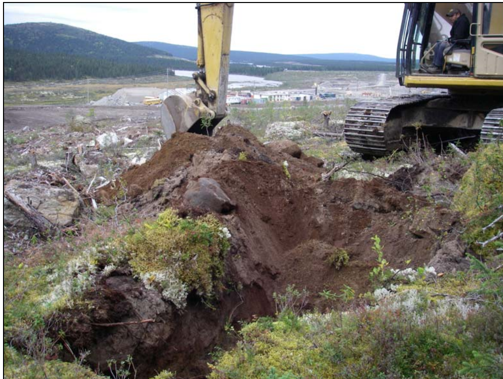
Photo 8 Travaux d'excavation effectués à l'aide d'une pelle hydraulique de la tranchée TR-140.
