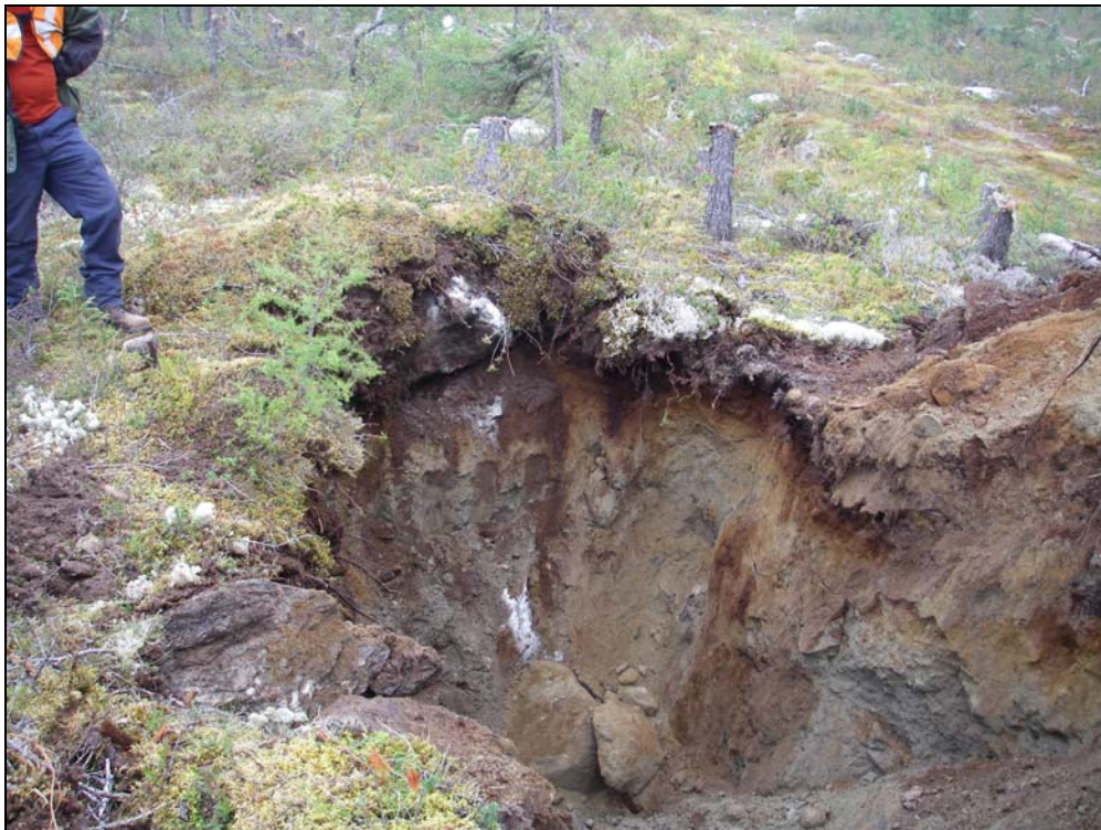
Photo 6 Travaux d'excavation effectués à l'aide d'une pelle hydraulique de la tranchée TR-153.
