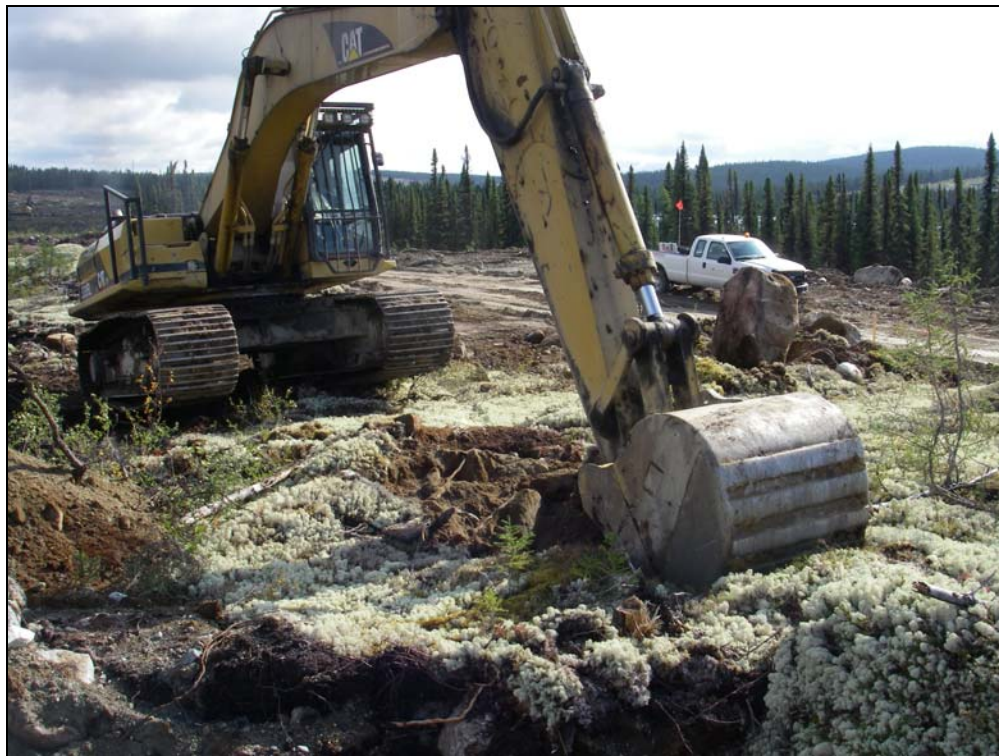
Photo 2 Travaux d'excavation effectués à l'aide d'une pelle hydraulique de la tranchée TR-112.
