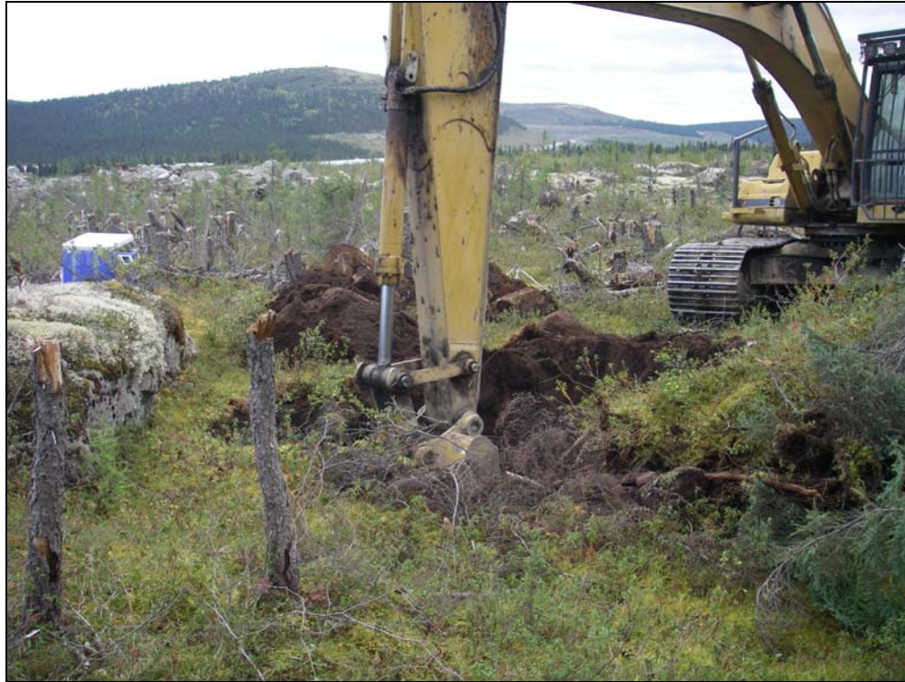
Photo 7 Travaux d'excavation effectués à l'aide d'une pelle hydraulique de la tranchée TR-155.
