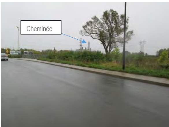
Photo 3-3 Cheminée des incinérateurs
