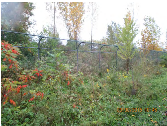
Photo 3-6 Clôture limitant l'accès à la station d'épuration
