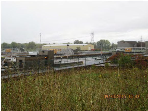
Photo 3-7 Décanteurs de la Station
