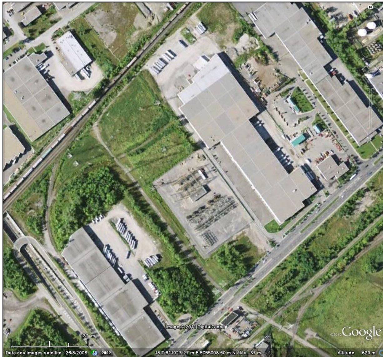
Figure 2.3 Photographie aérienne du poste Bourassa
