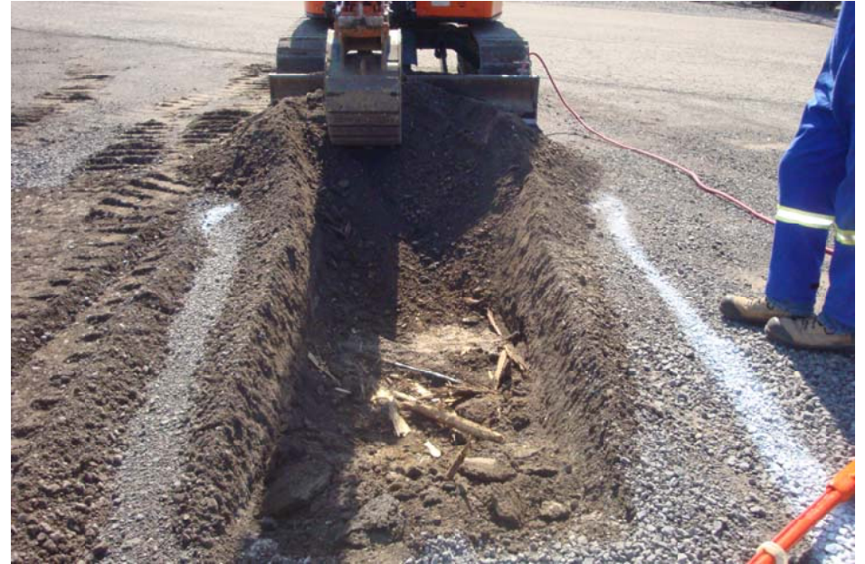
Photo 06_Tranchée T-03_Filage déterré.jpg
