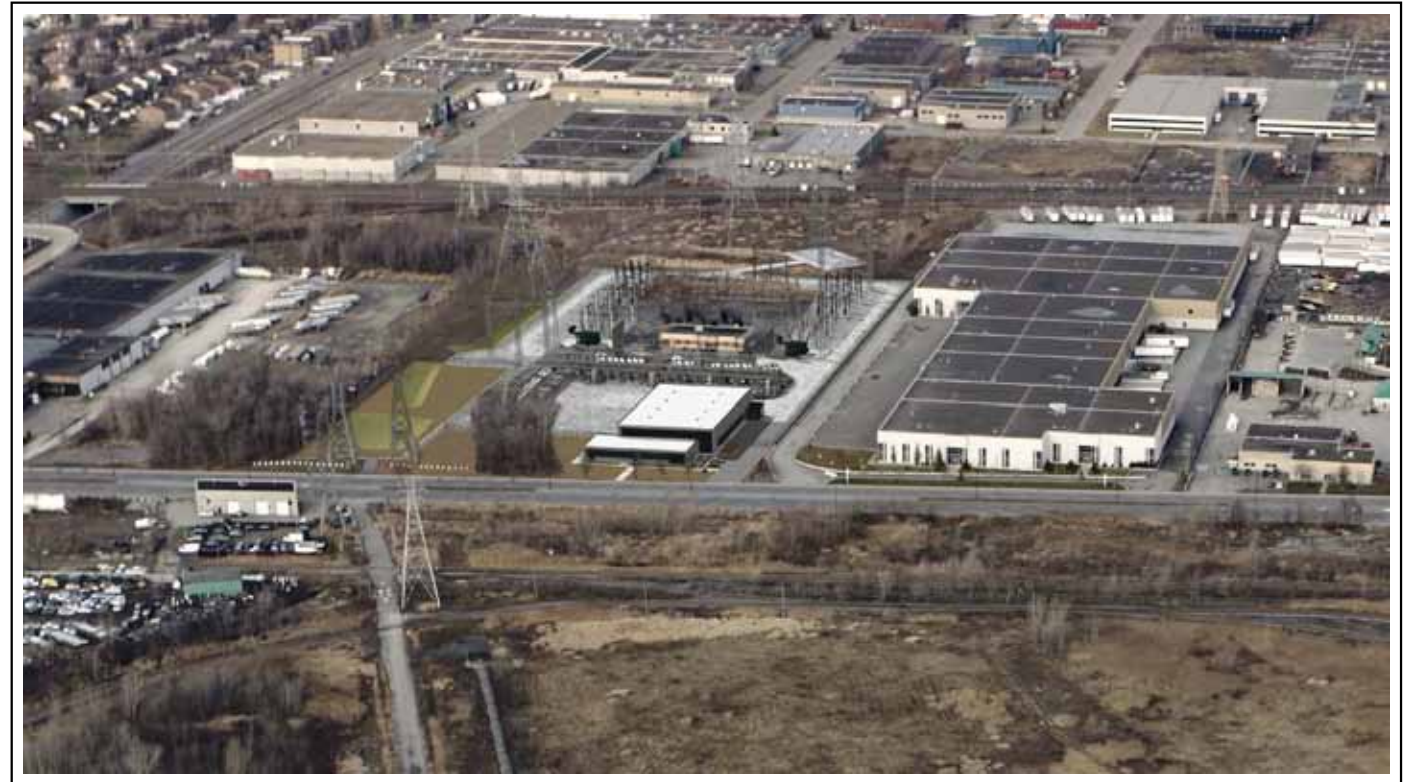
Situation en 2014 (à la mise en service du poste)
