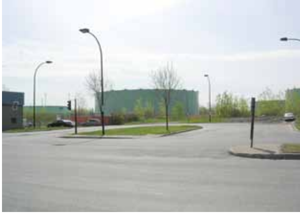
A. Réservoirs au sud du boulevard Henri-Bourassa Est
