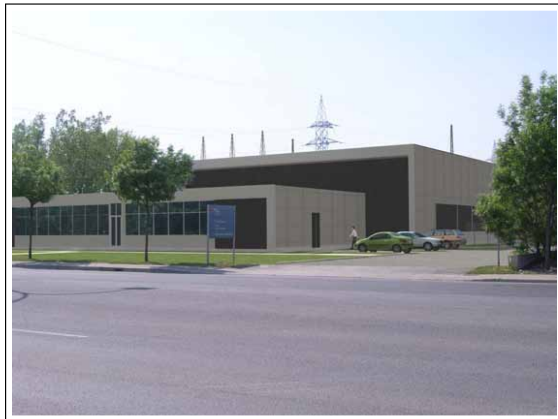
Situation en 2019 (après le démantèlement du poste à 120-12 kV)
