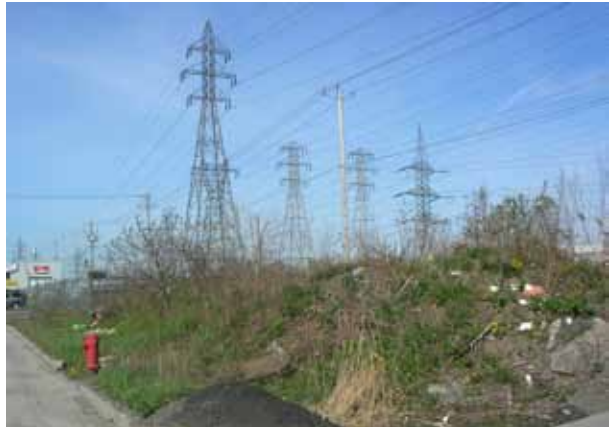
B. Emprise de lignes à 120 kV
