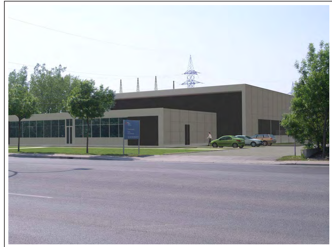
Situation en 2014 (à la mise en service du poste)
