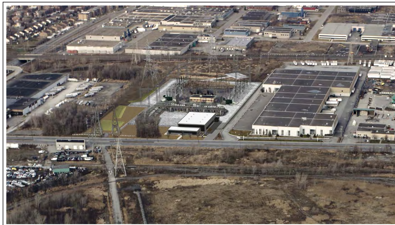
Situation en 2014 (à la mise en service du poste)
