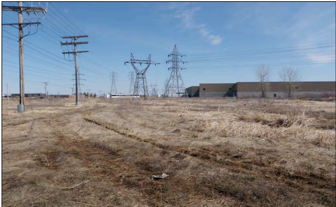
Photo 4-2 : Friche dans l'emprise de ligne située au nord-ouest du poste Bourassa
