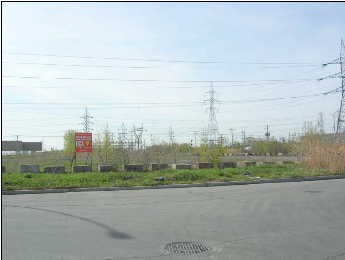
Photo 7-1 : Vue sur le poste Bourassa depuis la rue Pierre-Bonne, dans le parc industriel Rodolphe-Forget
