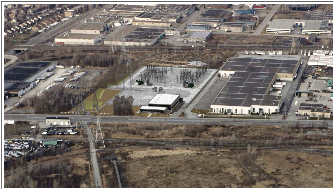
Situation en 2019 (après le démantèlement du poste à 120-12 kV)
