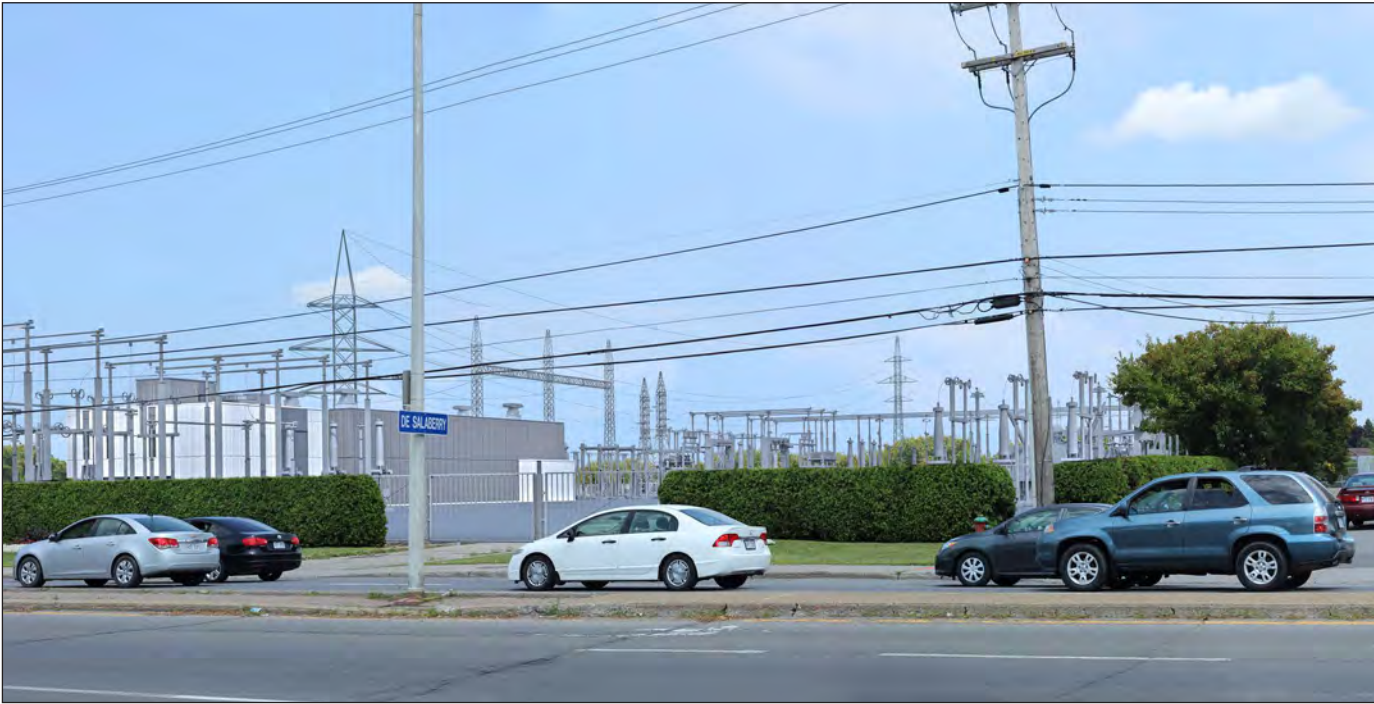
Situation future – Pylônes en treillis métallique à encombrement réduit
