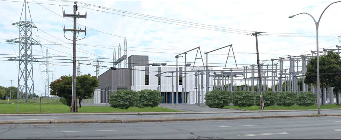
Situation future – Pylônes en treillis métallique à encombrement réduit
