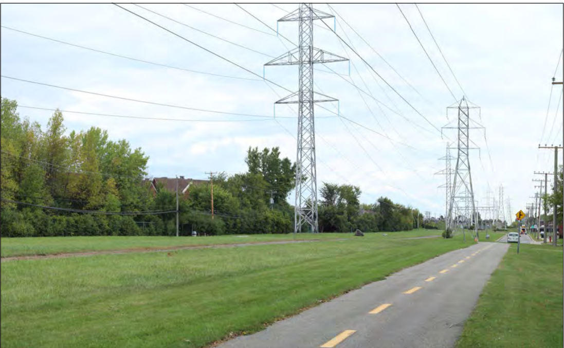
Situation future – Pylônes en treillis métallique à encombrement réduit
