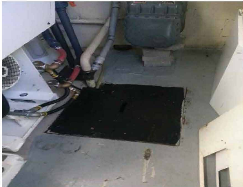
Photo 14 : Raccordement à l'aqueduc municipale
