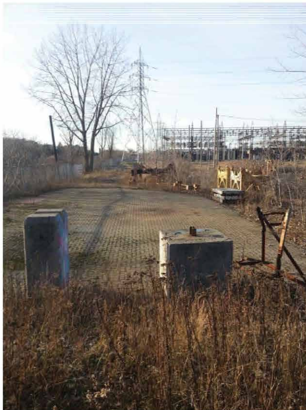
Photo 30 : Lot 1 488 875 vue vers le nord
