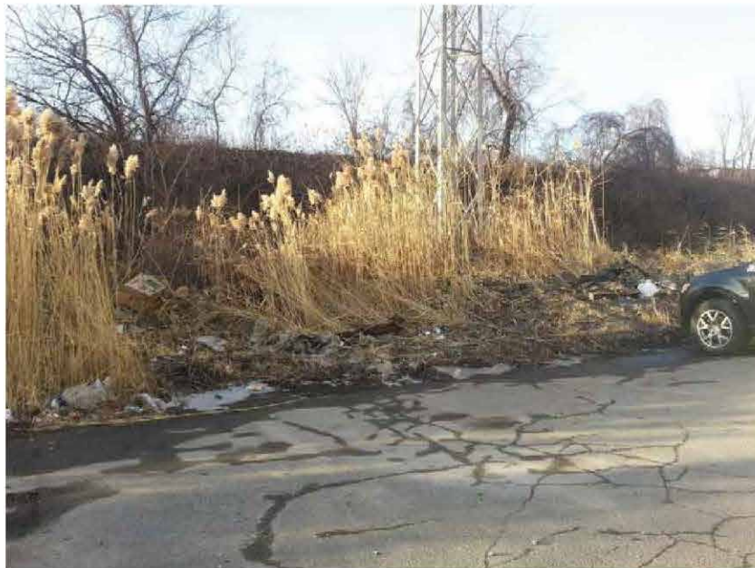
Photo 46 : Débris, secteur du pylône projeté No 3 vue vers le nord
