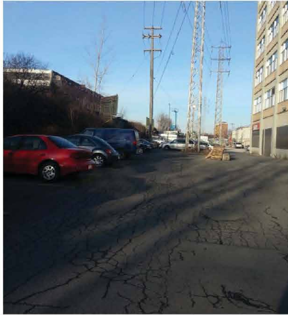
Photo 49 : Secteur du pylône projeté No 4, vue vers l'est
