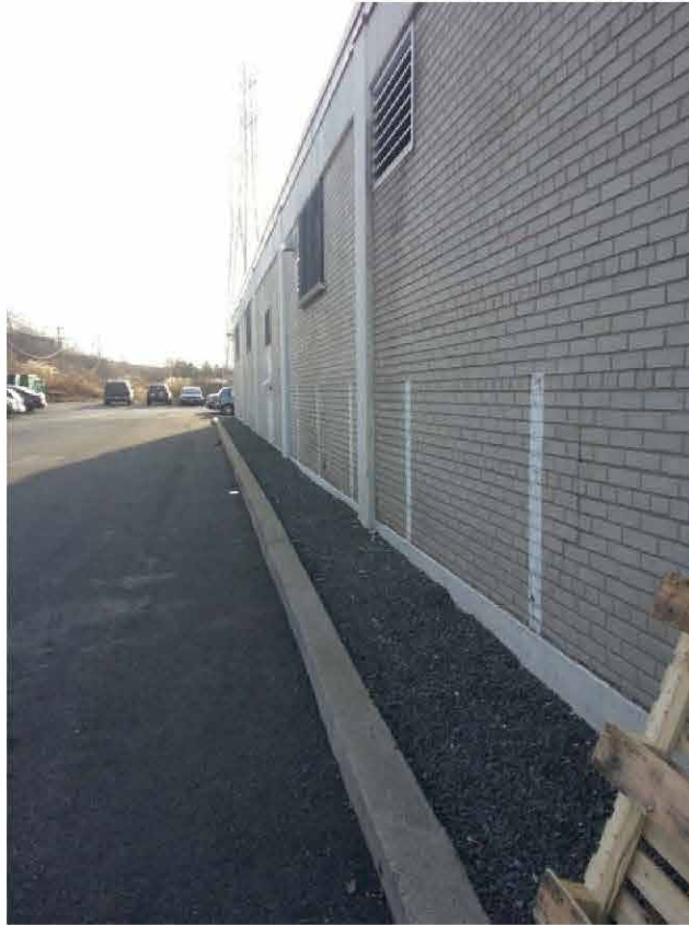
Photo 27 : Mur arrière du site de Lithobec, vue vers l'ouest
