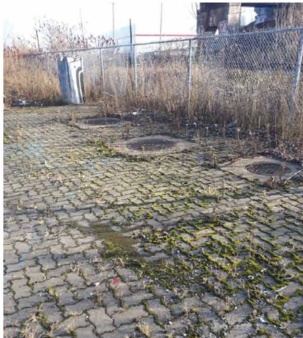
Photo 32 : Puisards sur le lot 1 488 875 (servitude de la Ville de Montréal) vue vers le sud-ouest
