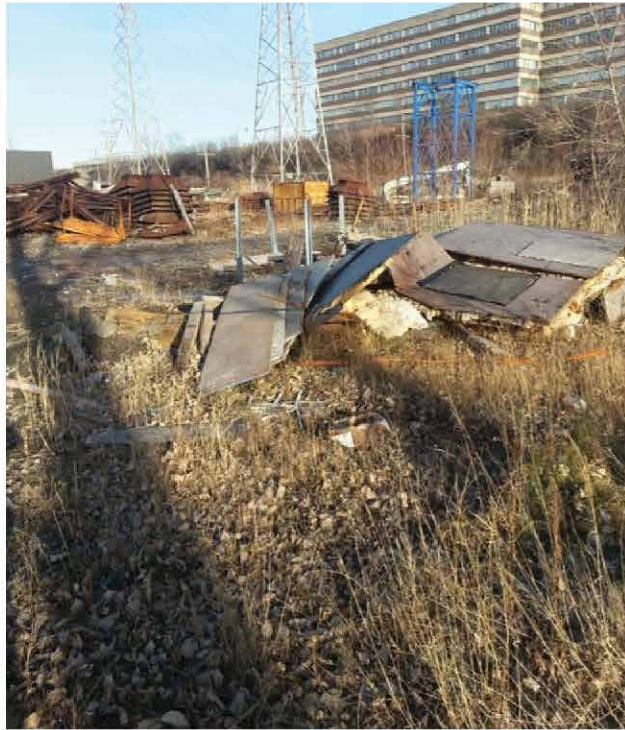
Photo 33 : Débris sur le lot 1 488 875 vue vers le sud-est
