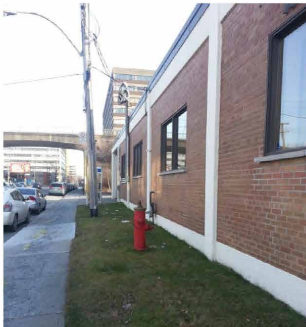
Photo 2 : Mur adjacent à la rue Meilleur, vue vers le sud
