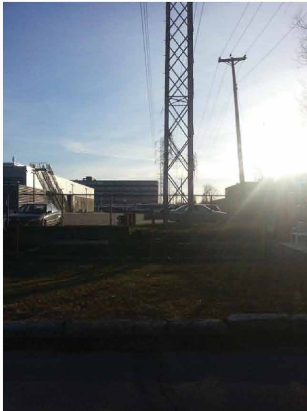
Photo 52 : À l'ouest du Centre de santé et de services sociaux, vue vers le pylône projeté No 5, vue vers l'ouest
