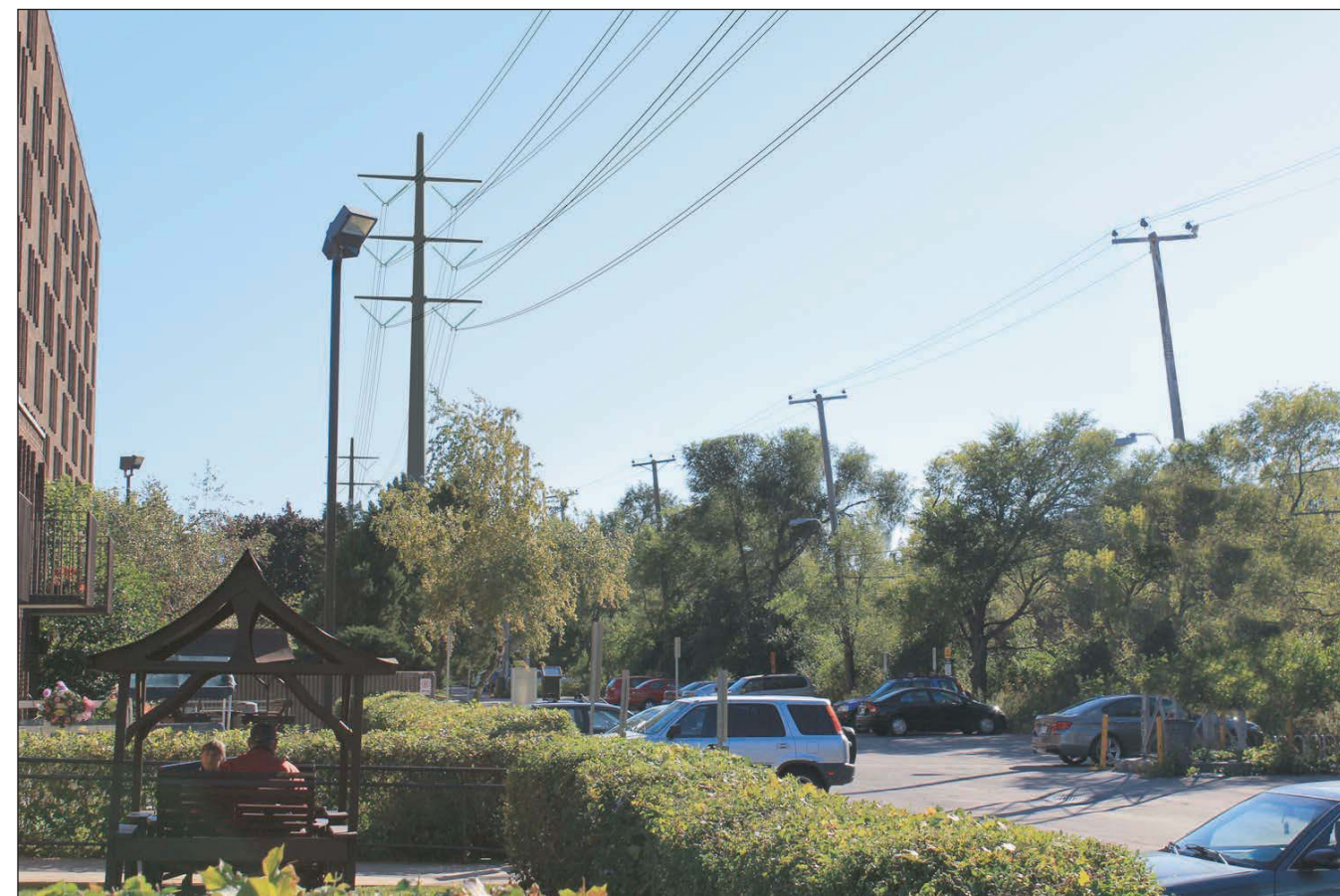
La simulation ne représente ni la maîtrise de la végétation ni l'aménagement multiusage.
