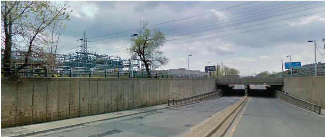
Photo 4-3 : Pont ferroviaire au croisement de la rue Sauvé et de la voie ferrée du CP et partie du poste Fleury (vue en direction ouest)
