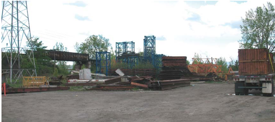
Photo 4-1 : Terrain destiné au poste Fleury projeté
