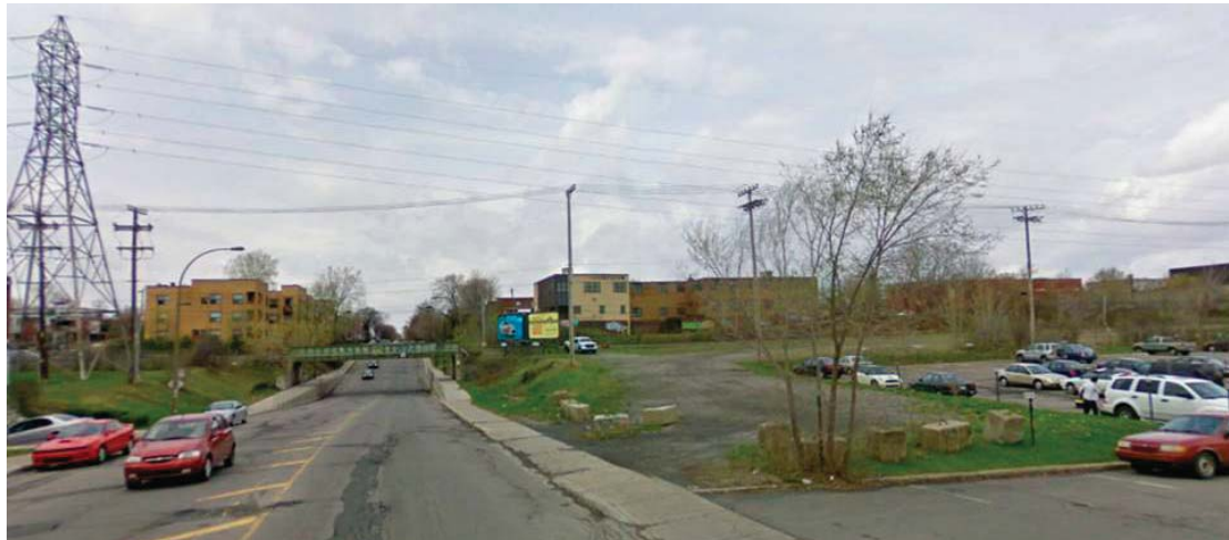
Photo 4-23 : Rue Saint-Hubert (vue en direction nord et sur la ligne à 120 kV)
