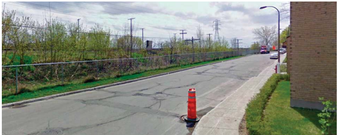
Photo 4-9 : Vue vers la ligne à 120 kV (circuits 1271-1272) à partir de l'intersection de la rue de Port-Royal Est et de l'avenue du Sacré-Cœur
