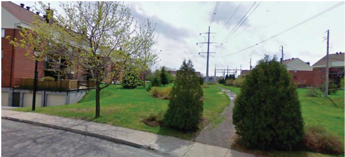
Photo 4-17 : Vue vers le poste Charland à partir de la rue Antoine-Déat
