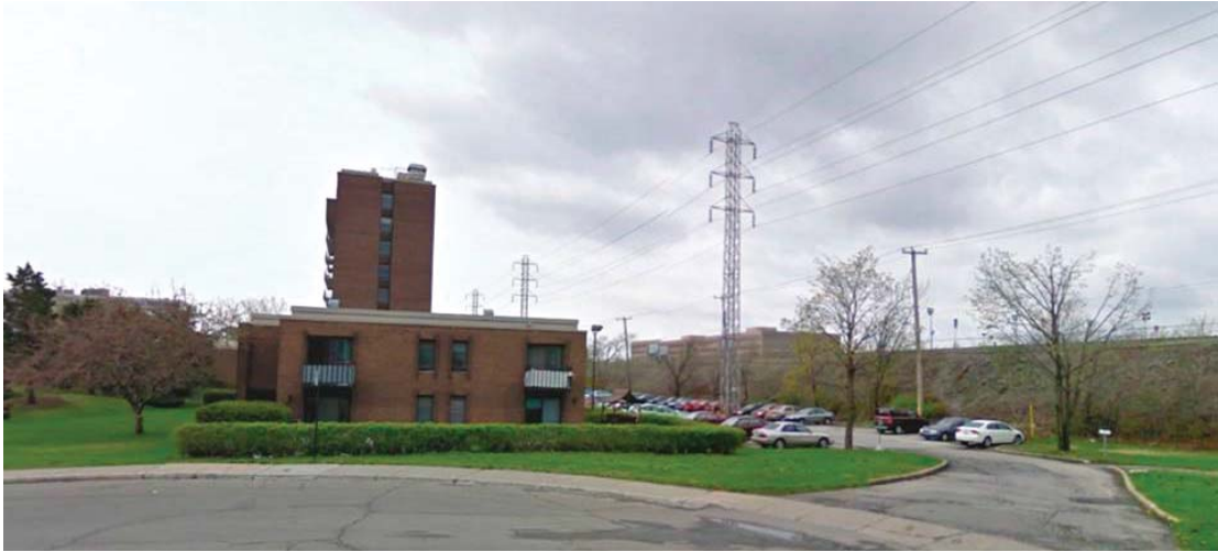
Photo 4-24 : CSSS d'Ahuntsic et Montréal-Nord et ligne à 120 kV (vue vers l'ouest)
