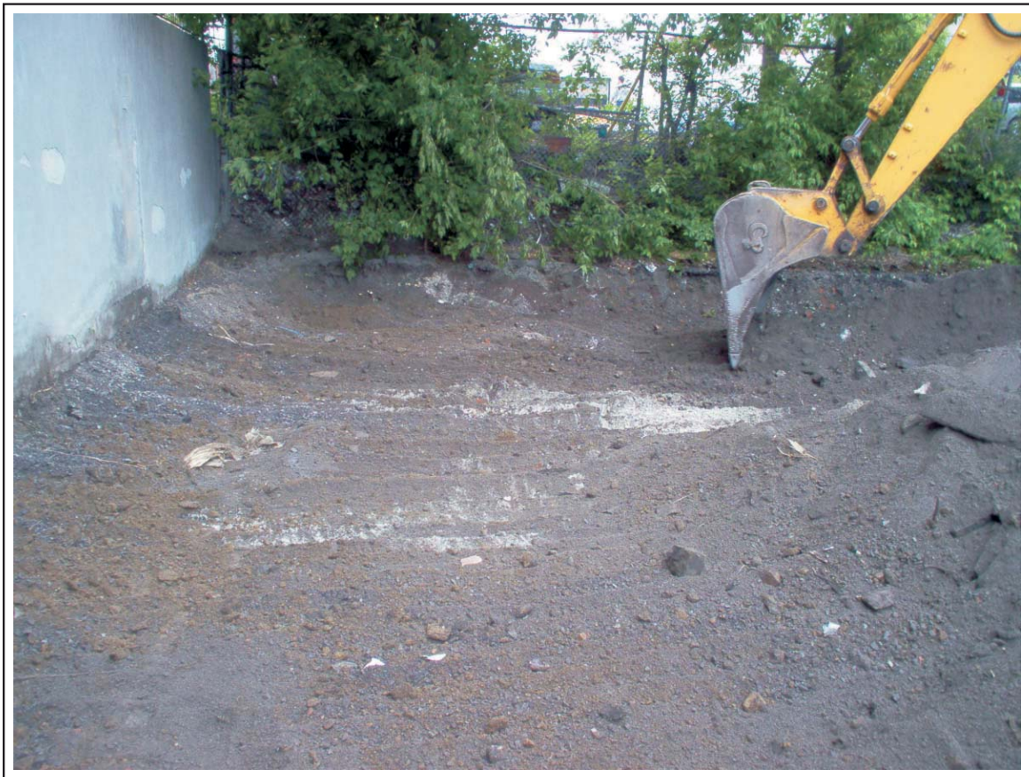
Photographie 1 : Secteur de l'excavation 1 (EXC-1) pendant les travaux.
