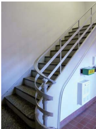
A. Lemarcis mercredi 24 novembre 2010 Escalier du hall d'entrée. Poste De Lorimier.
