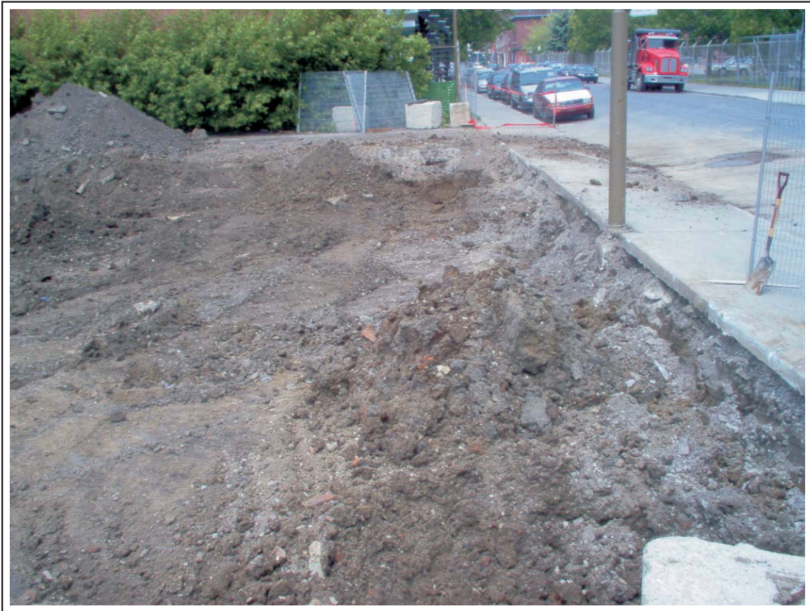
Photographie 3 : Secteur de l'excavation 3 (EXC-3) suite aux travaux.
