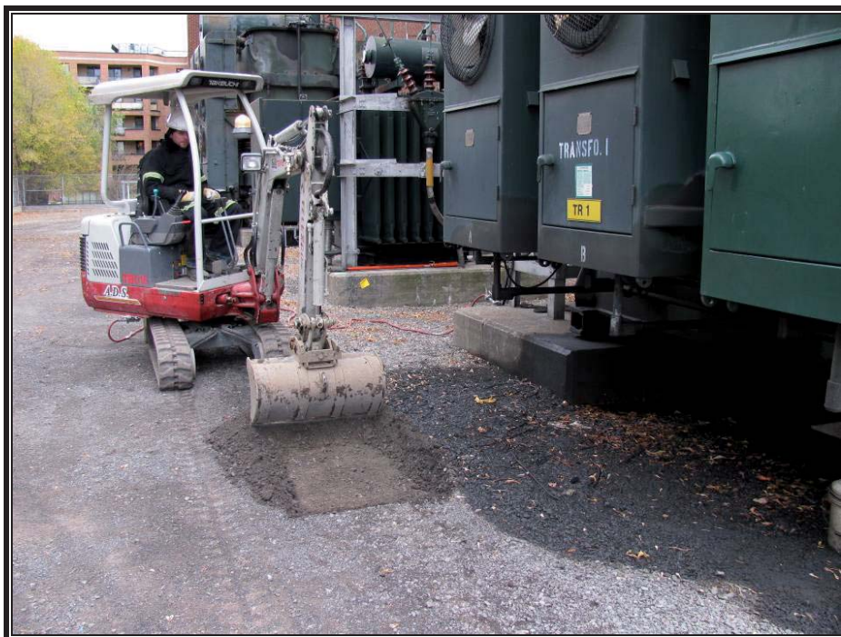
Photo 7 : Excavation de la tranchée TE-08-11 le long de la tâche d'huile (prise de vue sud, 11 novembre 2008).
