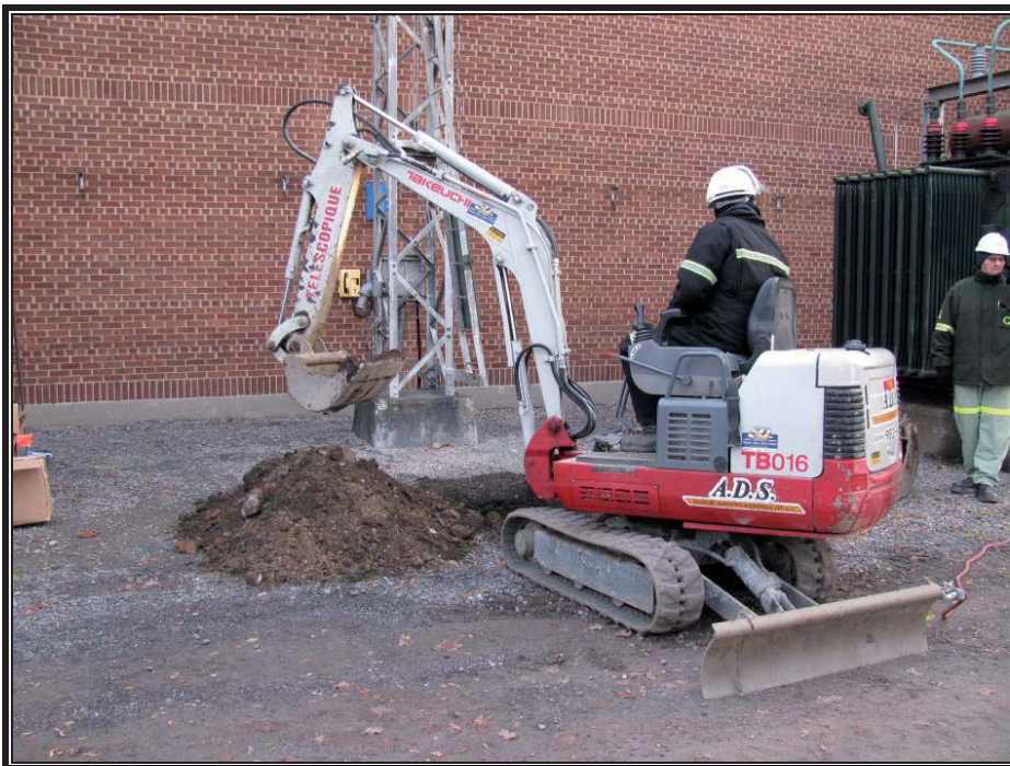
Photo 4 : Excavation de la tranchée TE-08-05 (prise de vue est, 11 novembre 2008).
