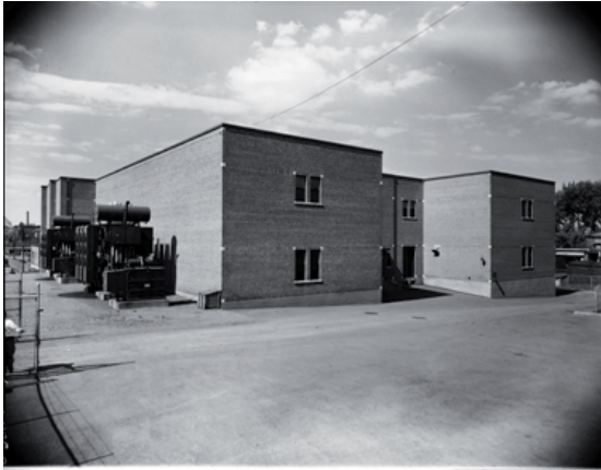
Bâtiment de commande. Poste De Lorimier.
