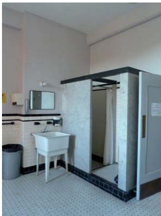
A. Lemarcis mercredi 24 novembre 2010 Salle de bain. Cloisons de marbre, plancher et demi-mur en céramique. Poste De Lorimier.
