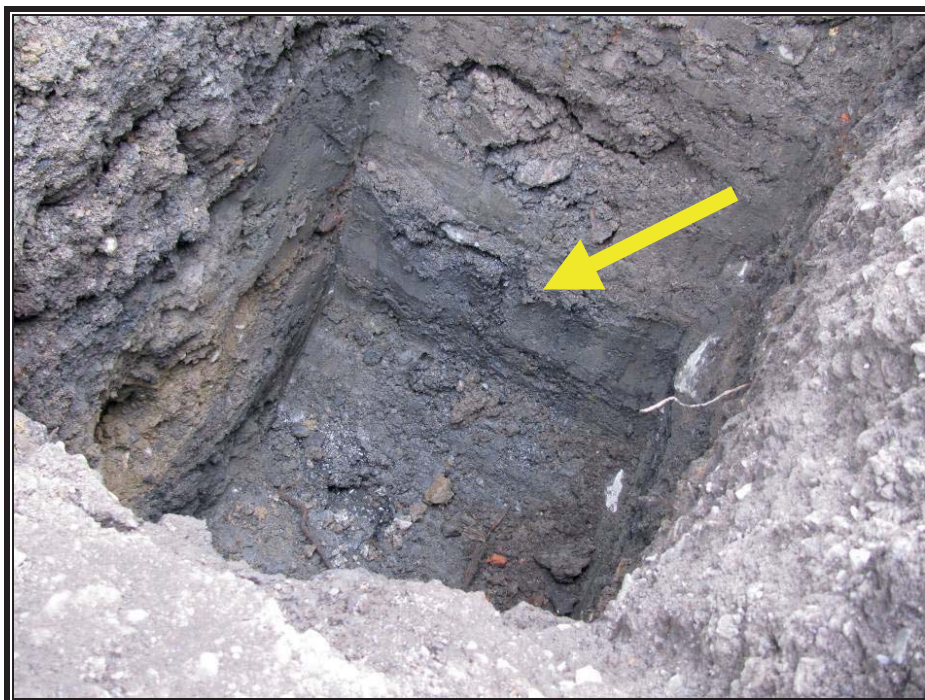
Photo 8 : Suintement d'huile dans la tranchée TE-08-11 (11 novembre 2008).
