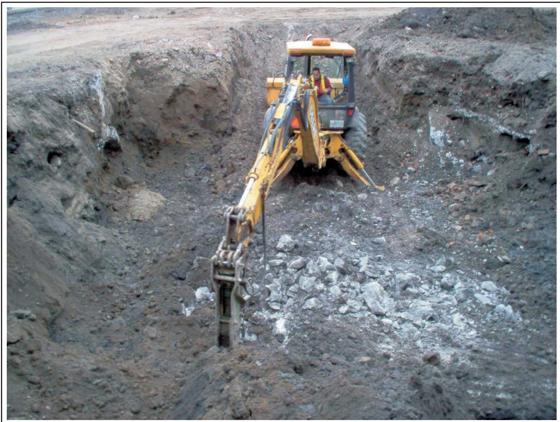
Photographie 4 : Démolition de la dalle de béton dans l'excavation 2 (EXC-2).
