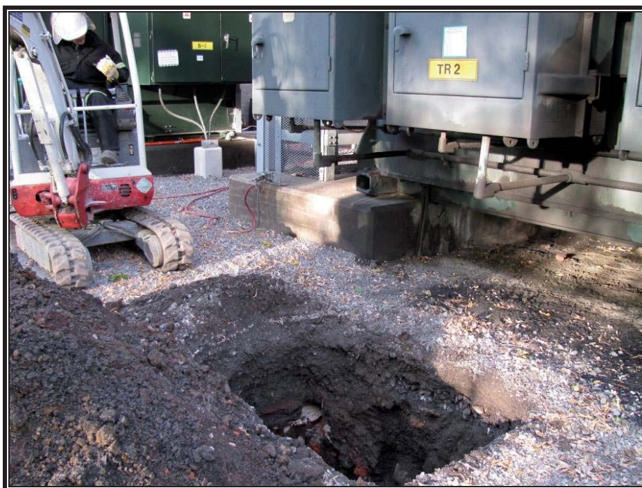
Photo 9 : Excavation de la tranchée TE-08-12 (prise de vue ouest, 11 novembre 2008).
