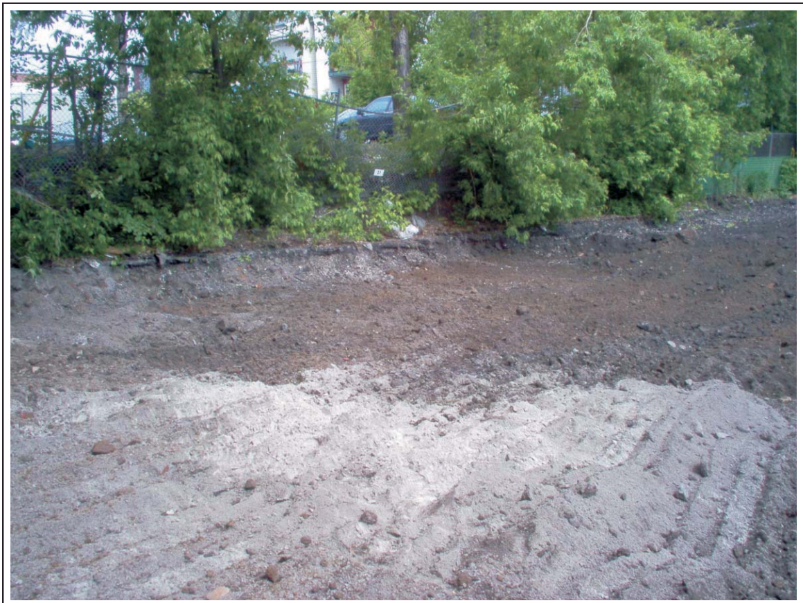
Photographie 2 : Secteur de l'excavation 1 (EXC-1) suite aux travaux.
