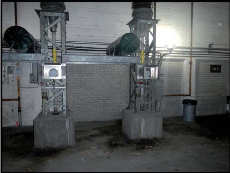
**Photographie 12.** Tache d'huile au sol dans la salle de manœuvre 120 kV.
