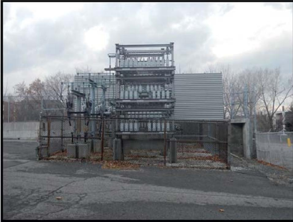
**Photographie 1.** Condensateurs au nord du bâtiment de commande.
