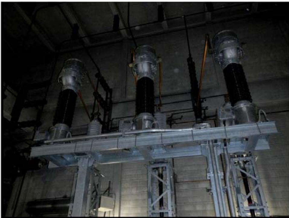
**Photographie 13.** Équipements contenant de l'huile dans la salle de manœuvre 120 kV.
