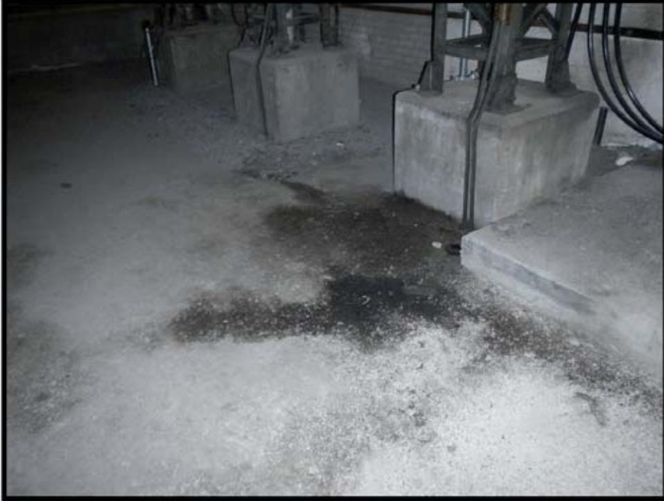
**Photographie 11.** Tache d'huile au sol dans la salle de manœuvre 120 kV.
