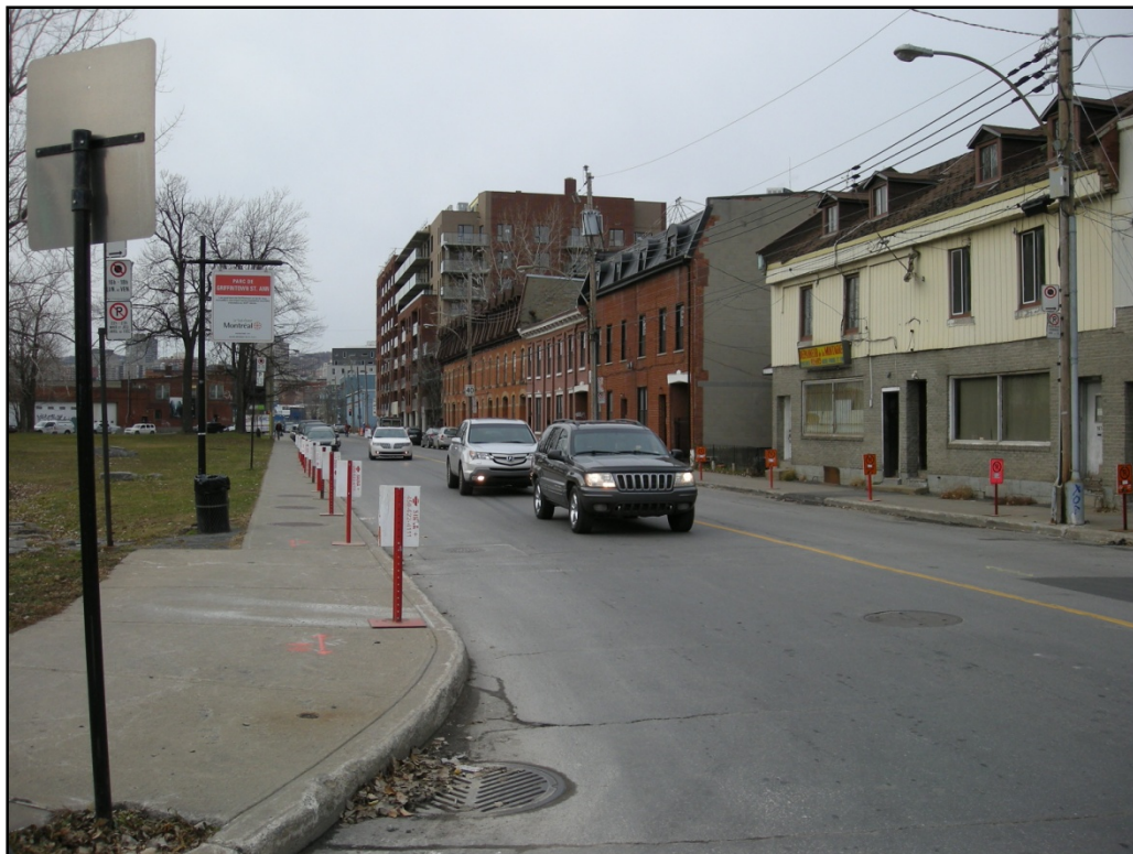
Photo 4 : Zone H2. Vue vers le nord-nord-ouest.
