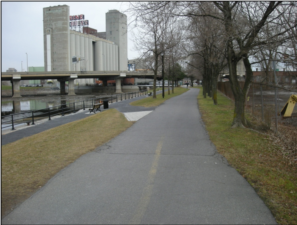
Photo 9 : Zone H6. Vue vers le sud-est.
