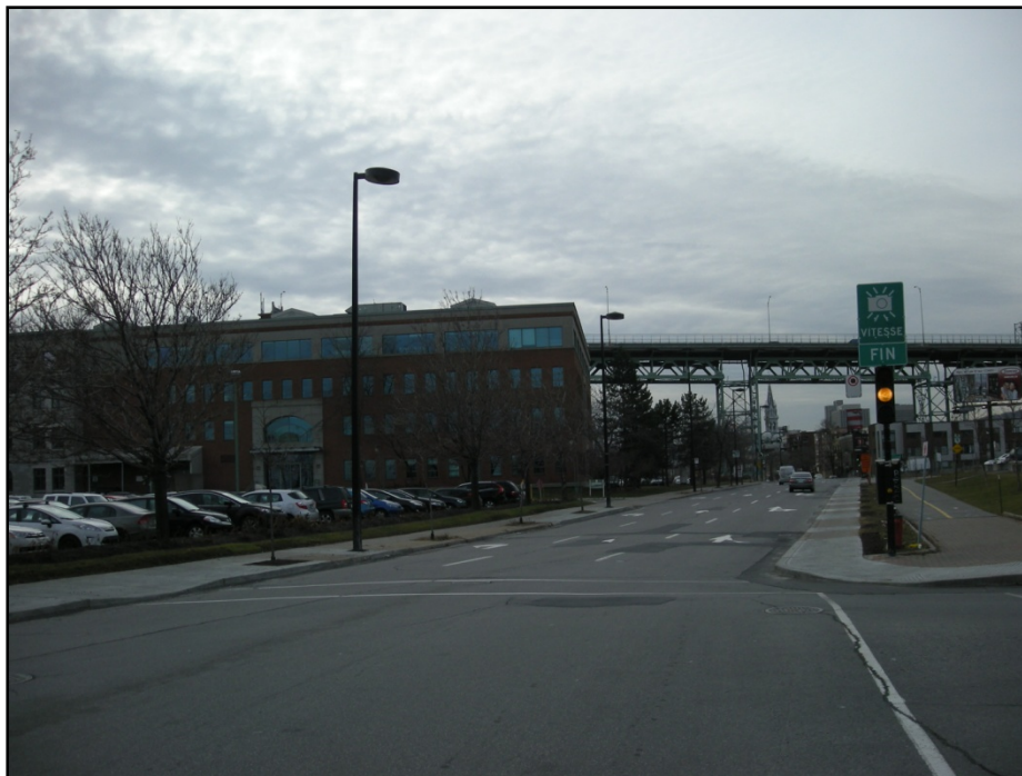
Photo 28: Zone H22. Vue vers l'ouest-sud-ouest.
