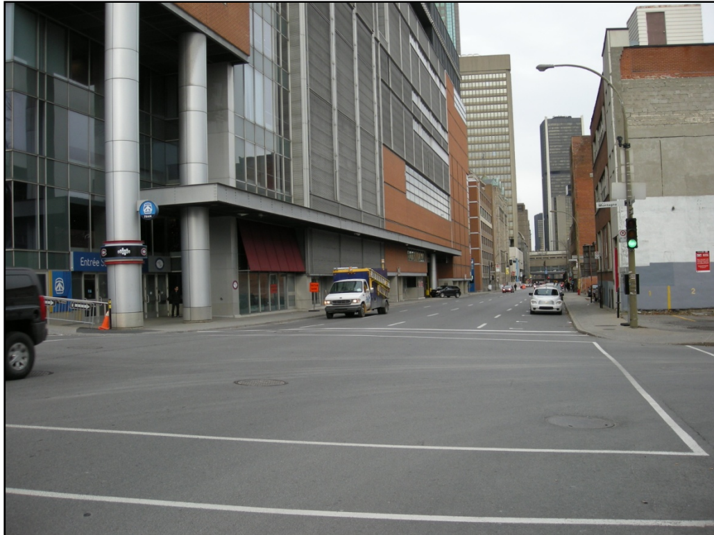
Photo 8 : Zone H5. Vue vers l'est.
