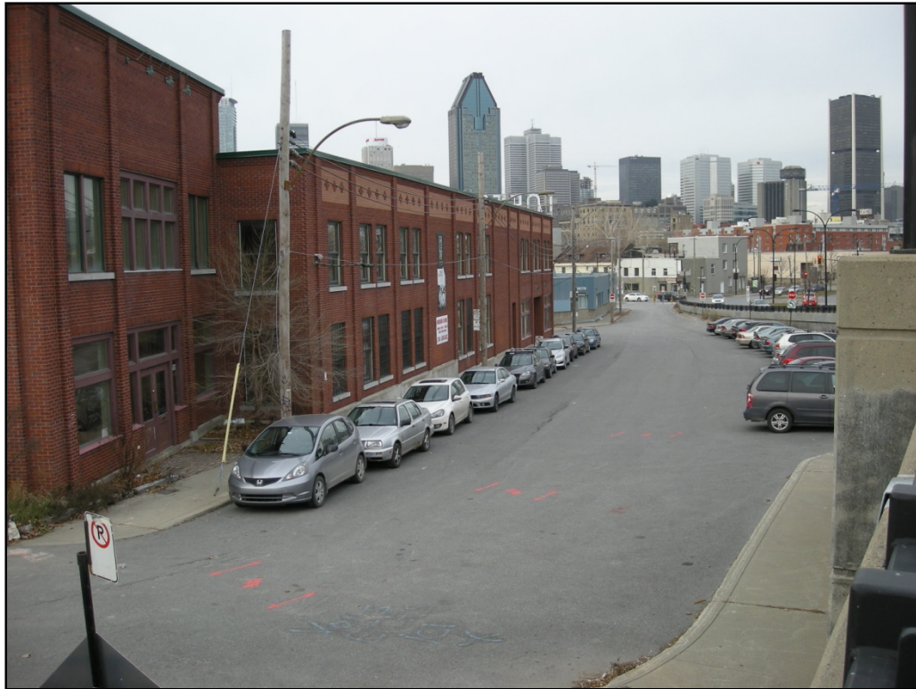
Photo 3 : Zone H1. Vue vers le nord-est.
