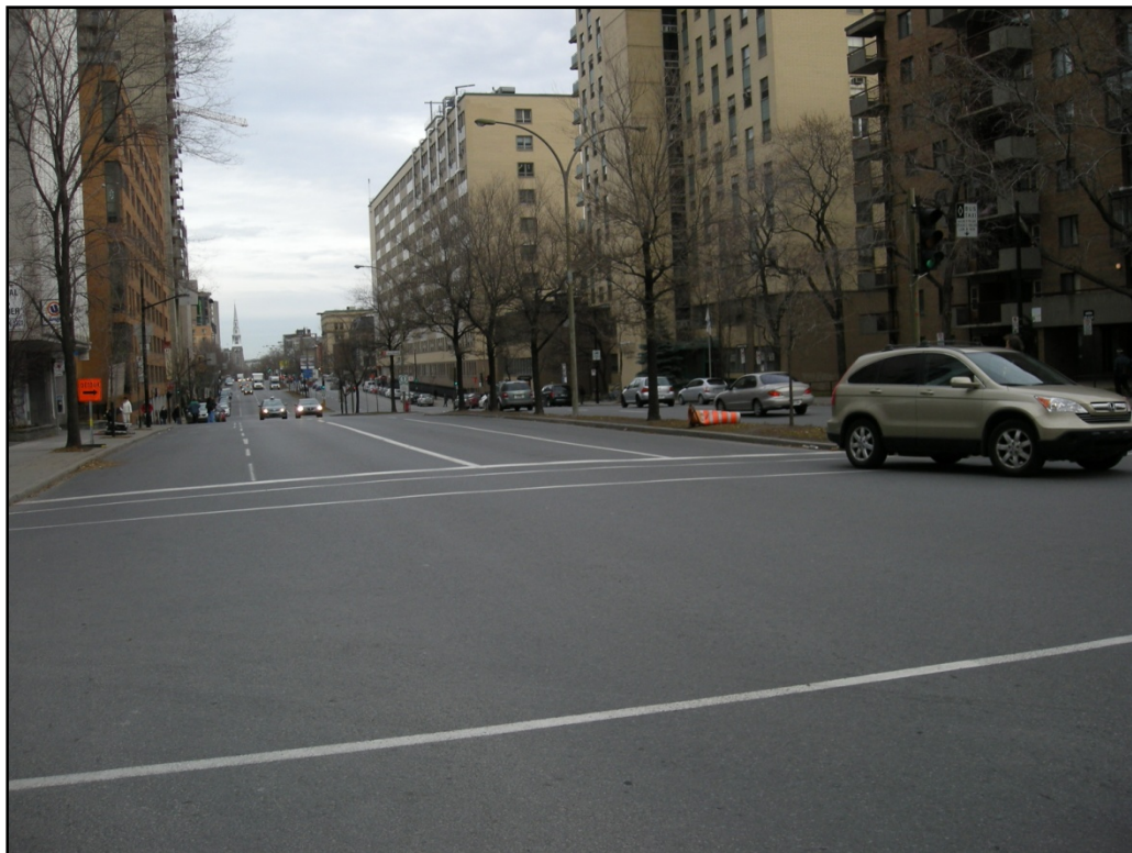
Photo 20 : Zone H14, portion est. Vue vers l'est.
