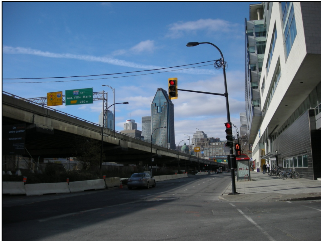
Photo 12 : Zone H9. Vue vers le nord-nord-ouest.
