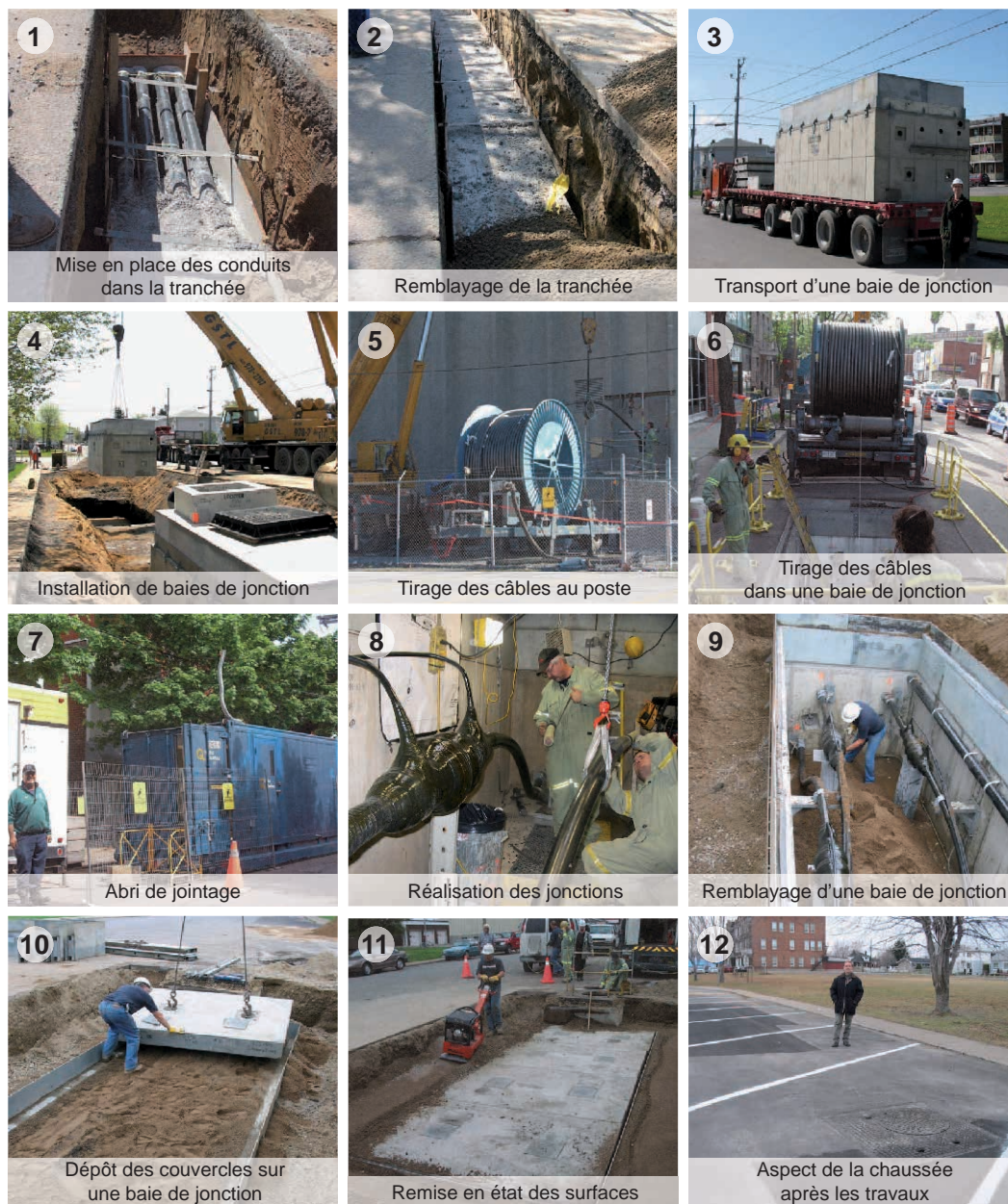
Figure 2 : Principales étapes de construction d'une ligne souterraine
