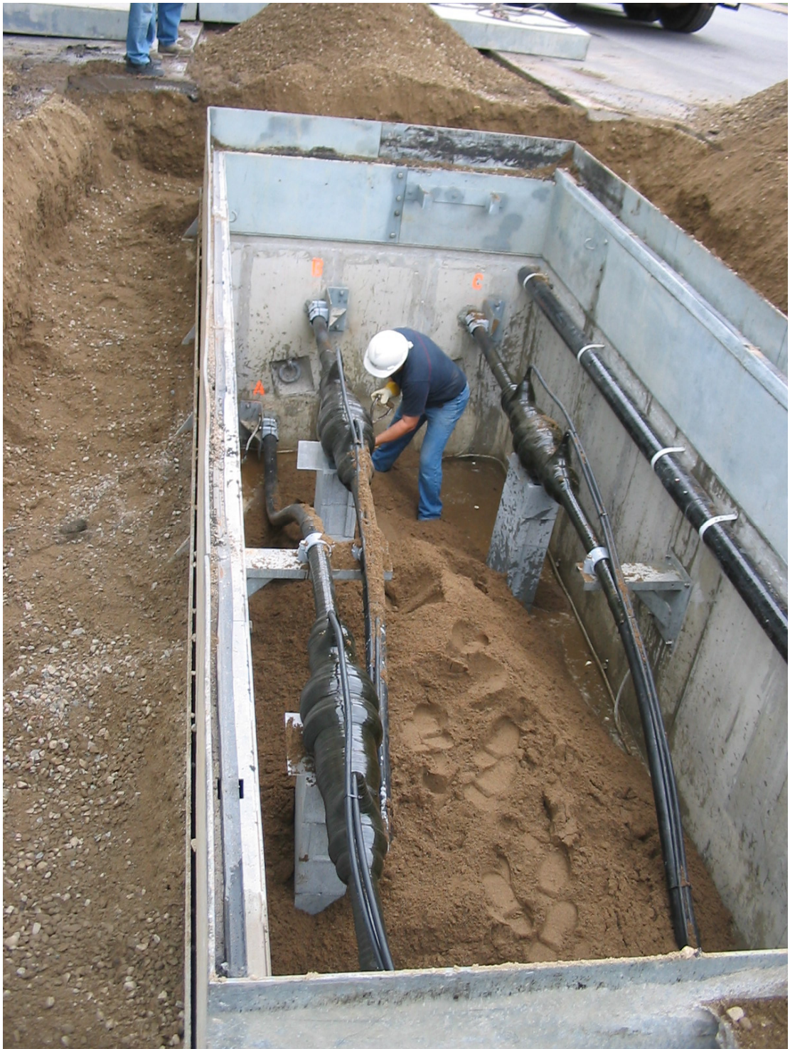
Photo 11 : Remblayage d'une baie de jonction
