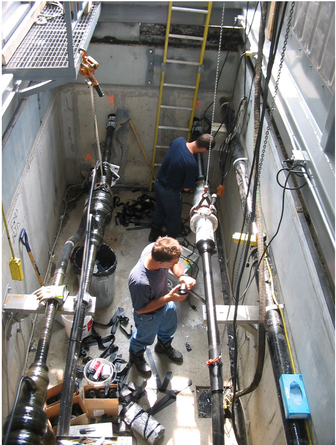
Photo 9 : Réalisation des jonctions
