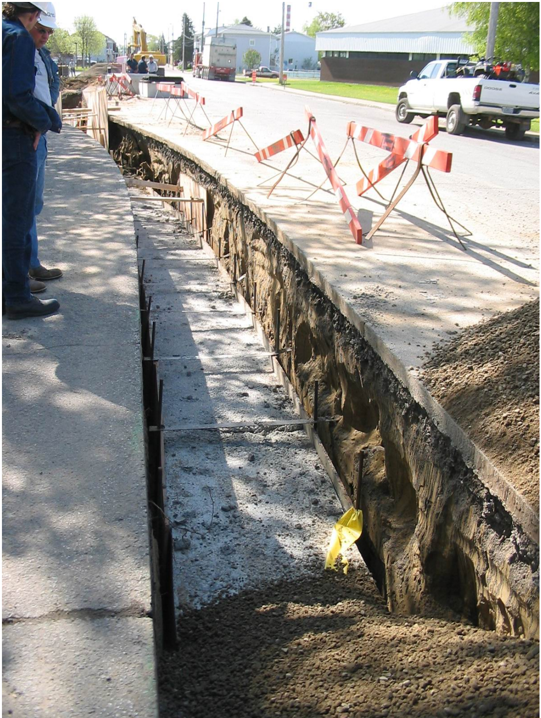
Photo 3 : Remblayage de la tranchée
