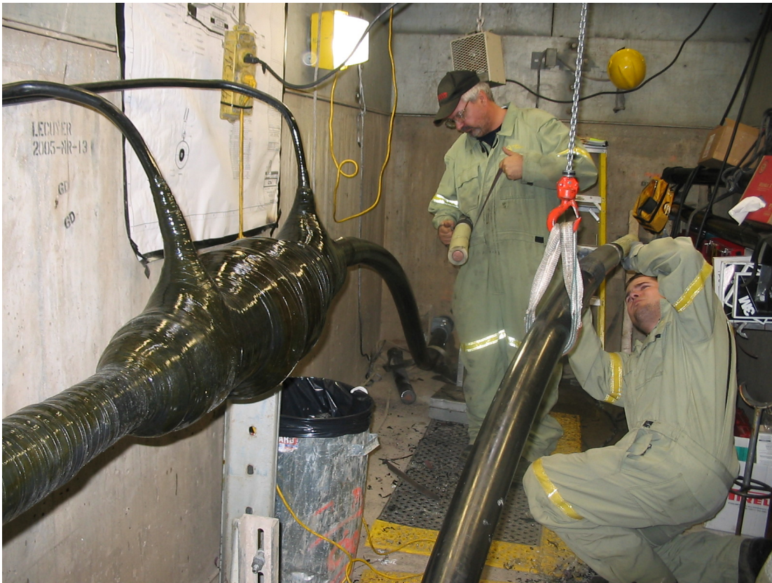
Photo 10 : Réalisation des jonctions
