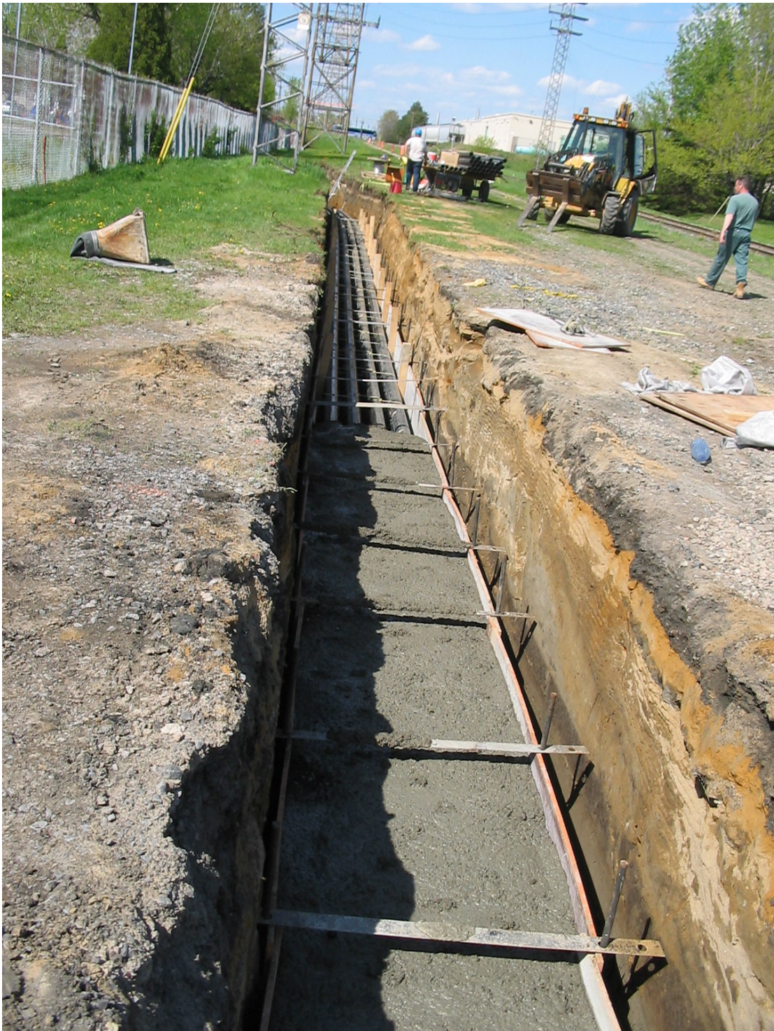
Photo 2 : Bétonnage de la canalisation
