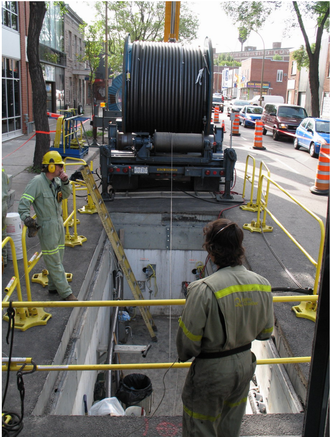
Photo 7 : Tirage des câbles dans une baie de jonction
