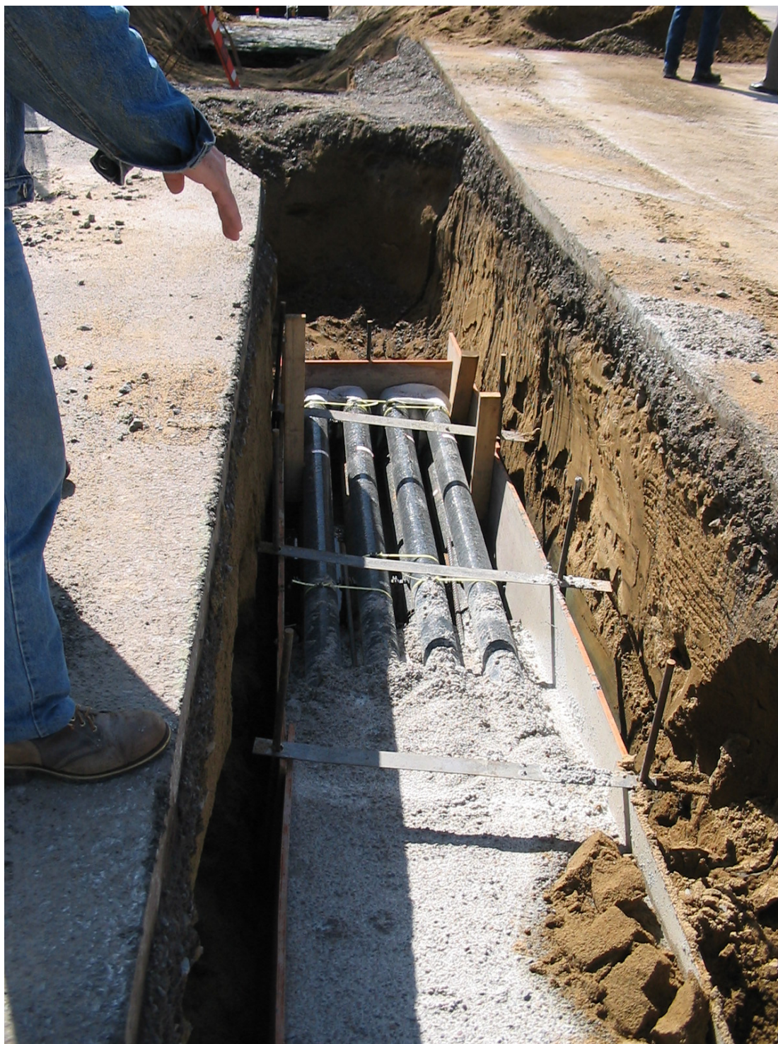
Photo 1 : Mise en place des conduits dans la tranchée
