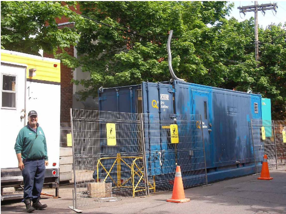
Photo 8 : Abri de jointage
