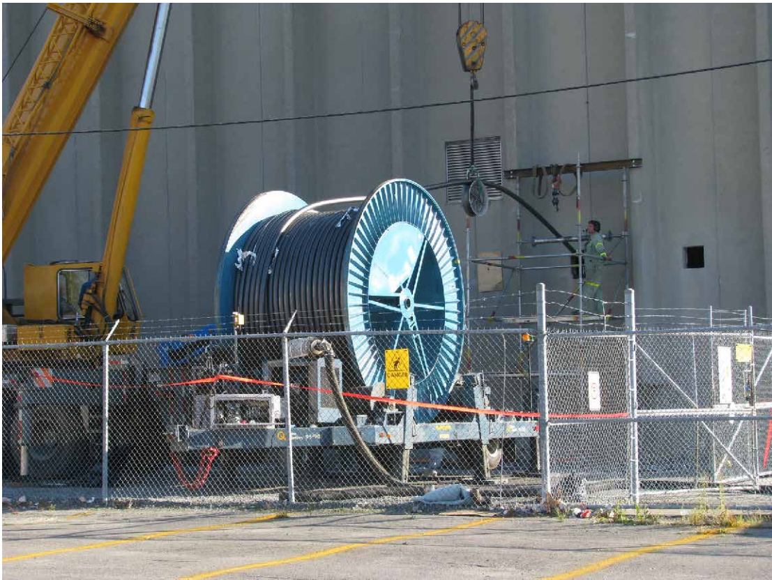
Photo 6 : Tirage des câbles au poste
