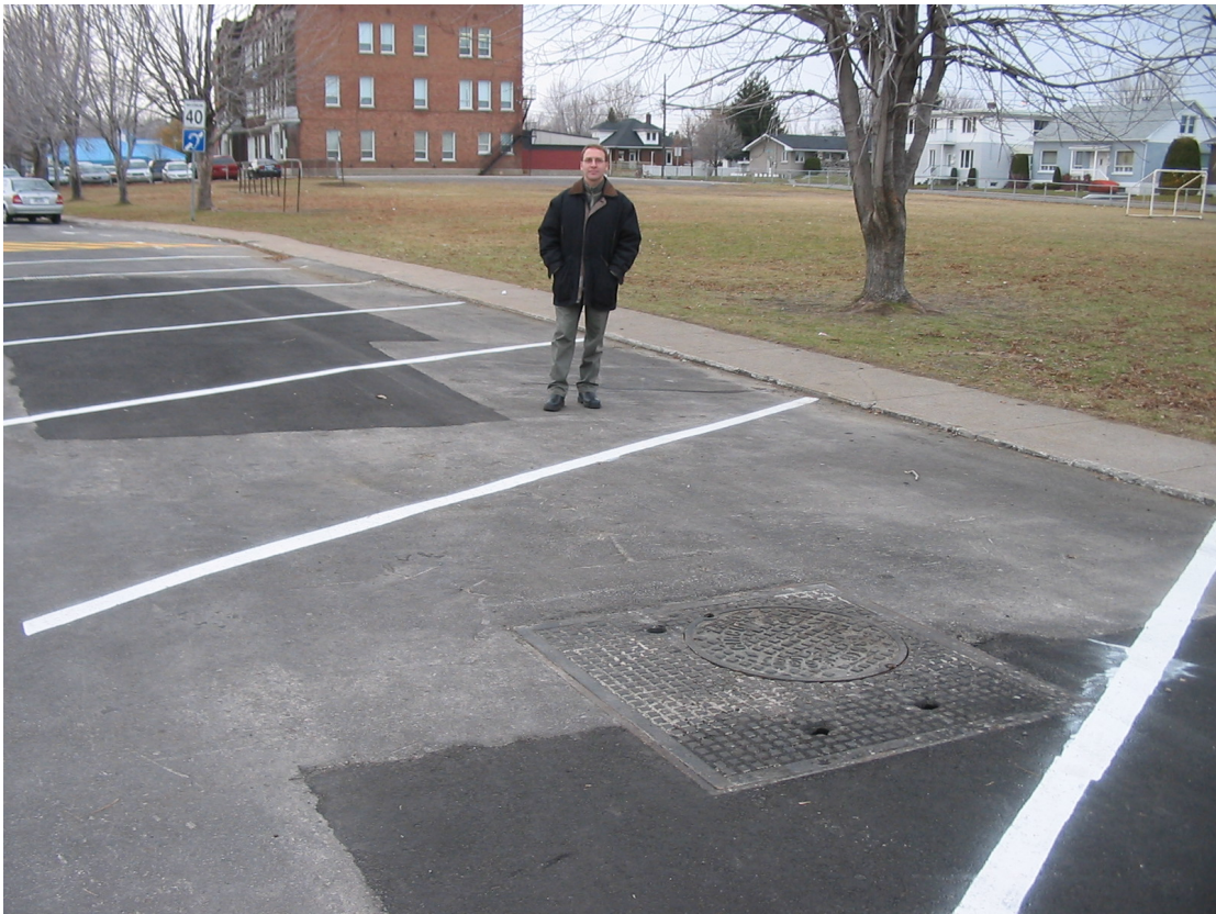
Photo 14 : Aspect de la chaussée après les travaux
