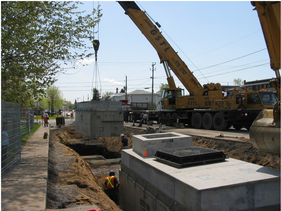
Photo 5 : Installation de baies de jonction
