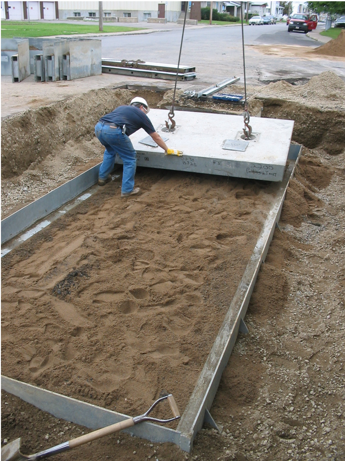
Photo 12 : Dépôt des couvercles sur une baie de jonction
