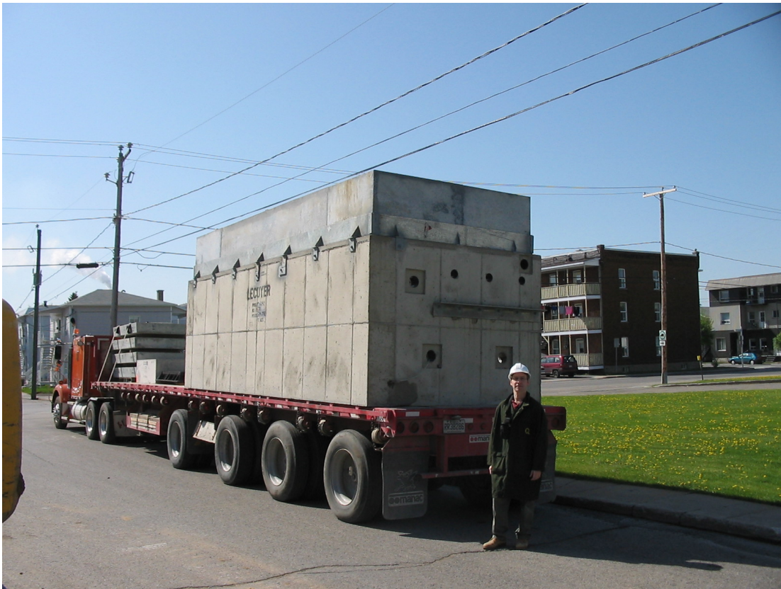
Photo 4 : Transport d'une baie de jonction
