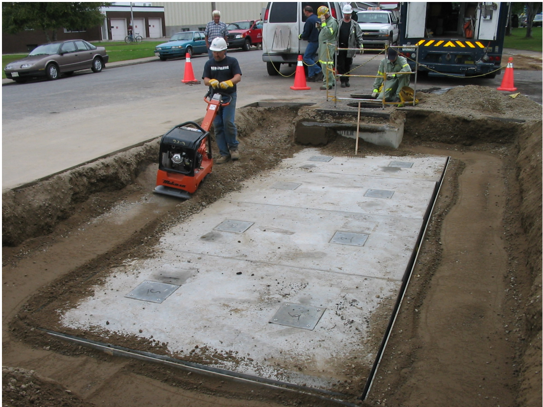
Photo 13 : Remise en état des surfaces
