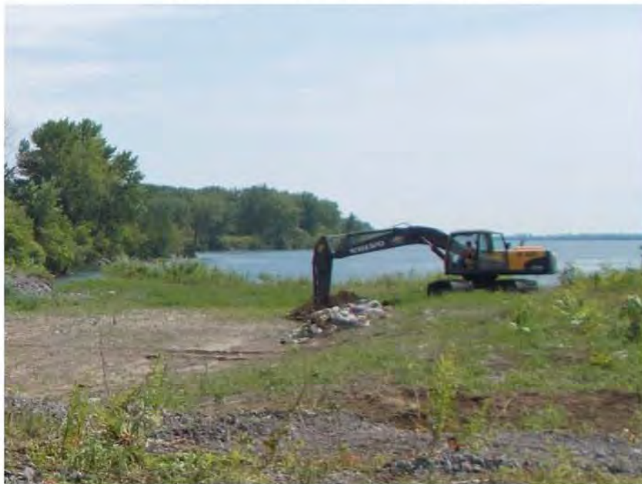
Photographie 11 : Travaux de sondages à la pelle mécanique
