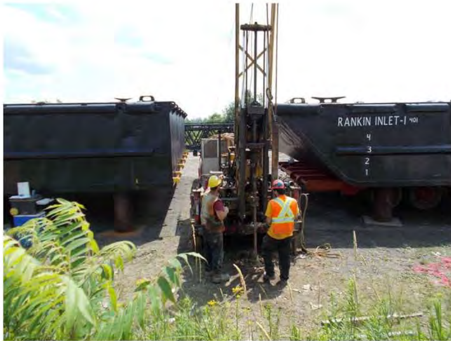
Photographie 11 : Travaux de forages
