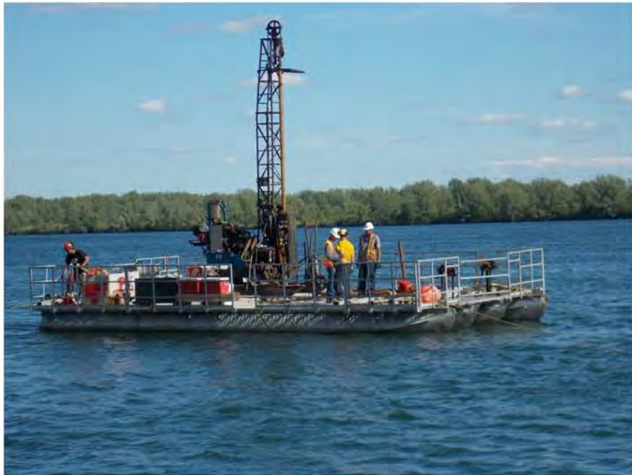
Photographie 10 : Travaux sur la barge
