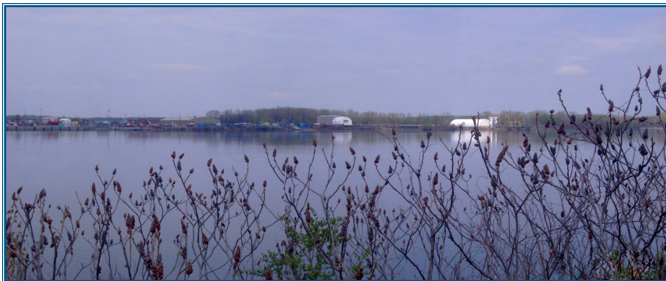
Photo 4-15 : Zone de travaux entre le quai n° 7 et l'ancien terminal de Grains supérieurs.
