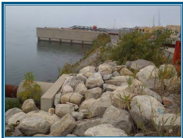
Photo 4-1 : Rive ouest de la zone des travaux.
