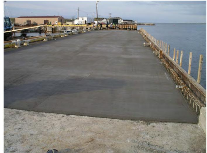
Figure 3.6 (Suite) : Exemple de projet de construction d'une dalle sur pieux.
