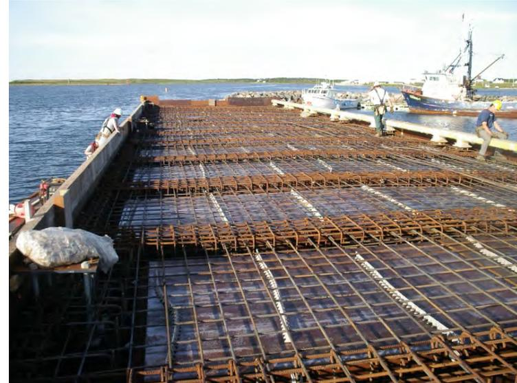
Figure 3.6 : Exemple de projet de construction d'une dalle sur pieux
