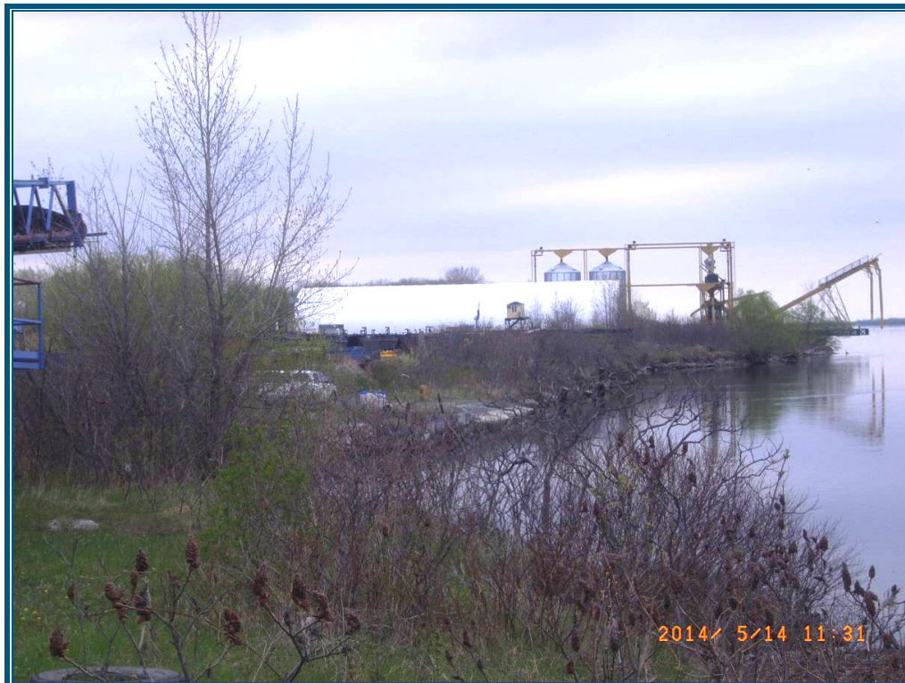
Photo 3 : Vue générale du site de l'agrandissement du quai.
