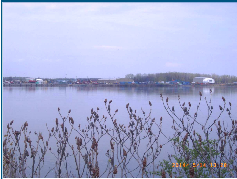
Photo 9 : Vue des installations portuaires à partir de la berge sud du canal de Beauharnois, le long de la piste cyclable.
